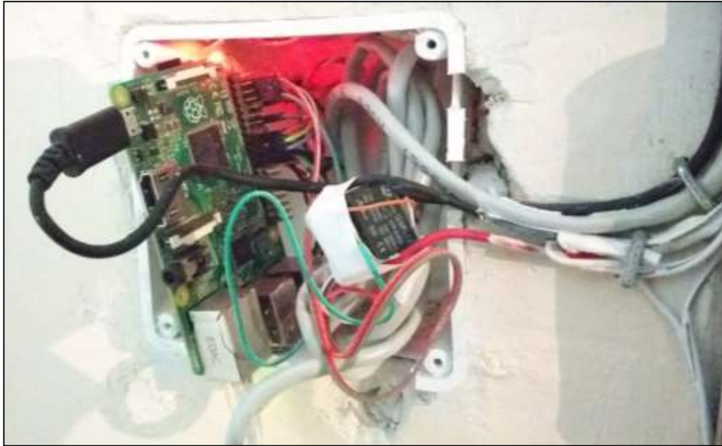
Figura 3.37: Instalación del sistema en su ubicación final
