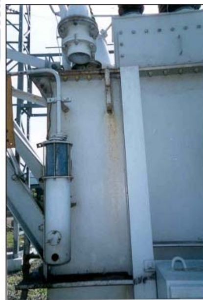
FIGURA 2.39. SECADOR DE SILICA GEL MONTADO EN UN TRANSFORMADOR
