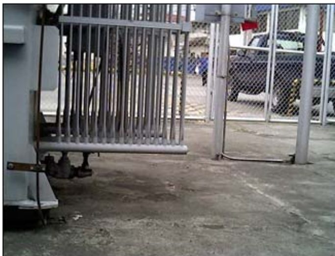
FIGURA 2.40. VALVULA PARA MUESTREO, FILTRADO Y DRENAJE DE ACEITE 2.3 METODOLOGÍA DEL MANTENIMIENTO PREVENTIVO PARA TRANSFORMADORES DE POTENCIA
