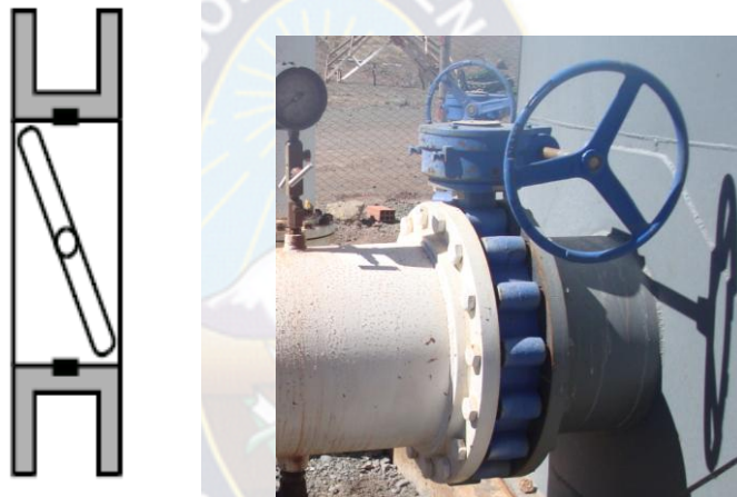
Figura. 2.19 Válvula tipo mariposa.
