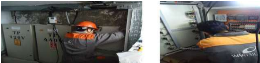
Figura 58 Montaje de TTA.
