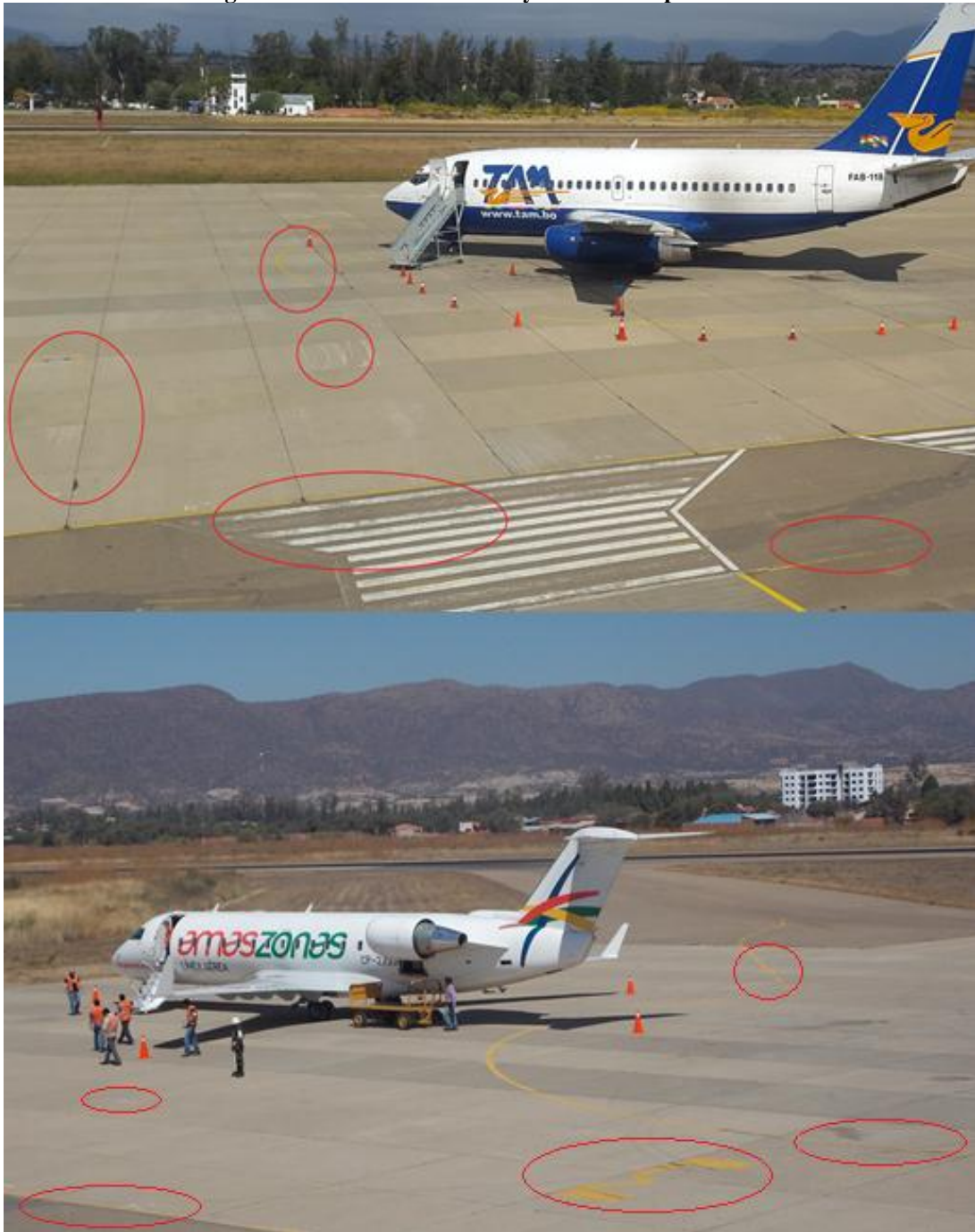
Figura N° 12. Señales borrosas y confusas en plataforma
