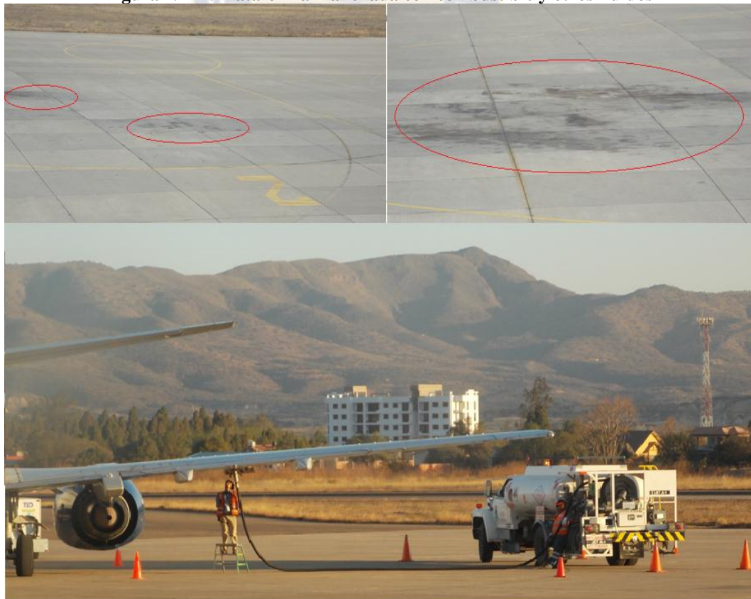
Figura N° 17. Plataforma manchada con combustible y otros fluidos
