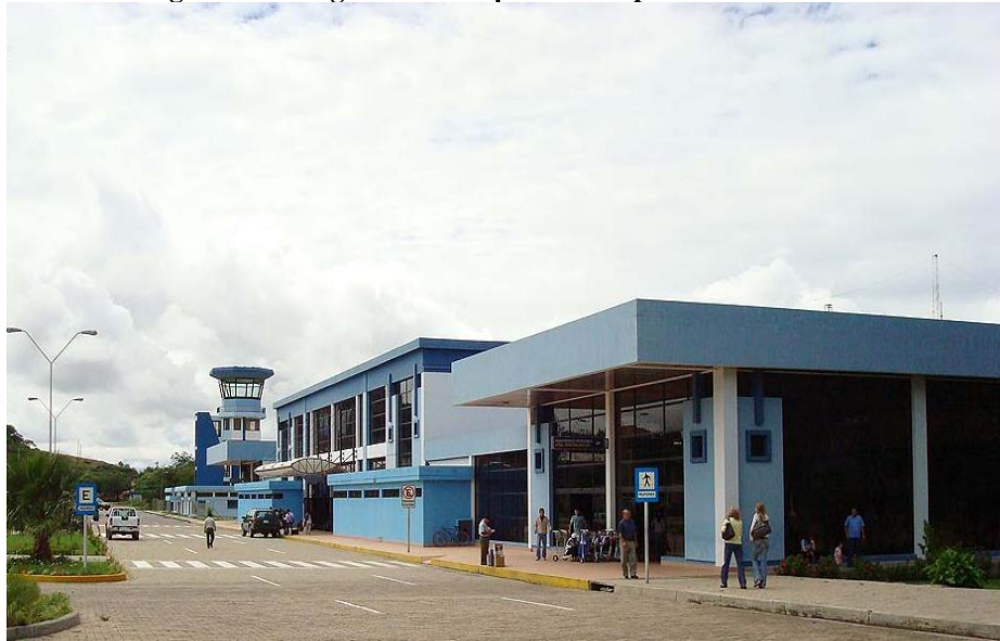
Figura N° 2. Ingreso al Aeropuerto “Cap. Oriel Lea Plaza”
