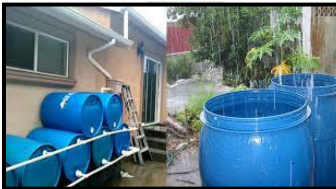
Figura 5: Abastecimiento de aguas pluviales
