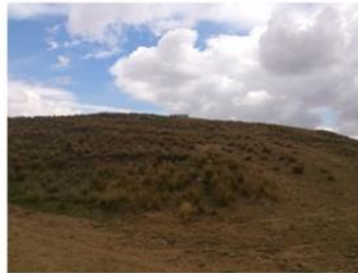
Tanque elevado, distribución por gravedad
