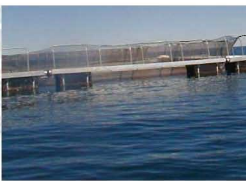
Es metálica, tiene pasillos amplios con vallas, el tamaño de la jaula es de 10 x 10 m. Los flotadores son de plastoformo forrado y son varios, esta clase es muy cara que las demás.
