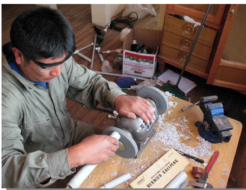
Lijado de las asperezas en los tubos PVC
