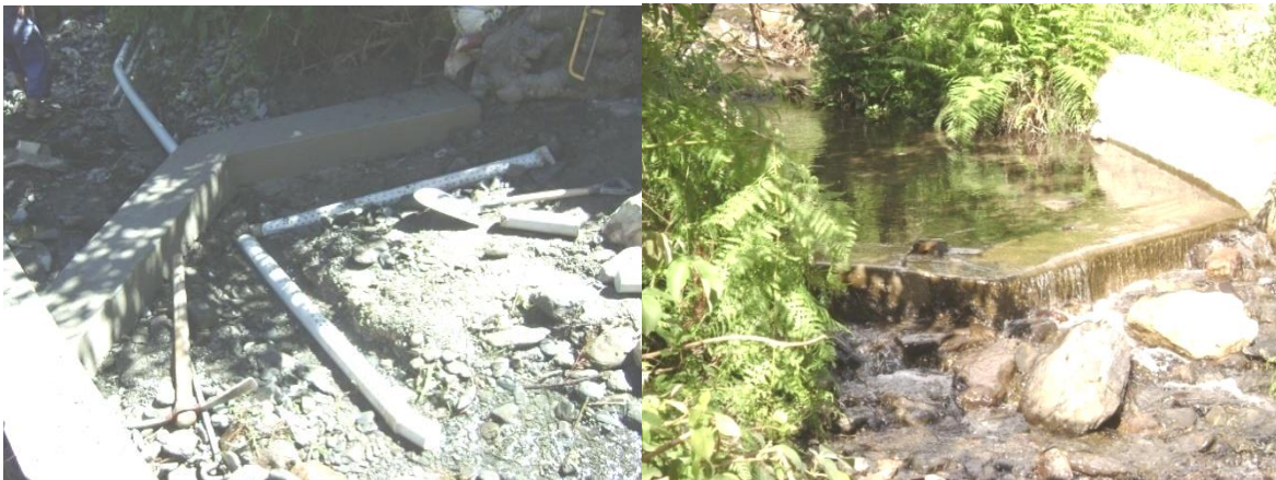
Figura 13. Obra de captación
