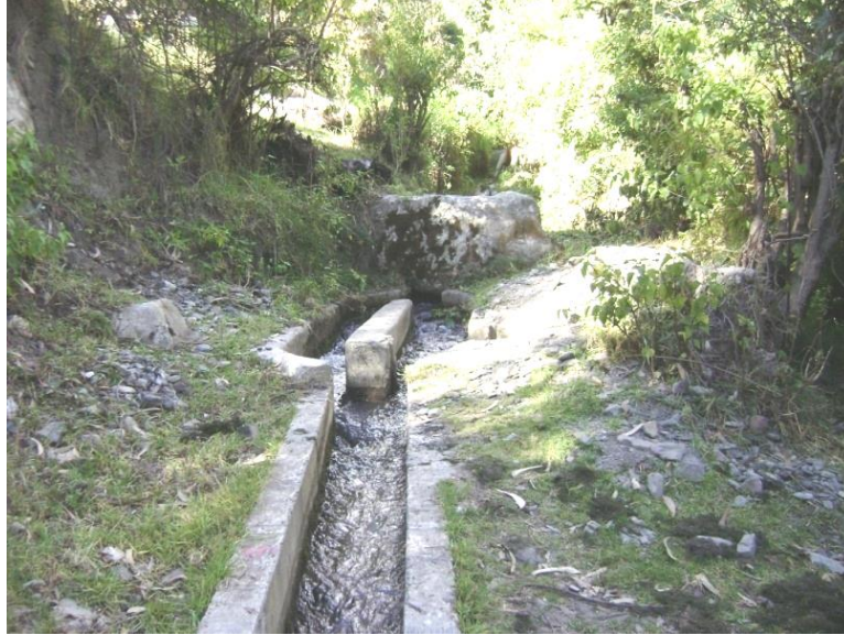
Figura 10. Desarenador
