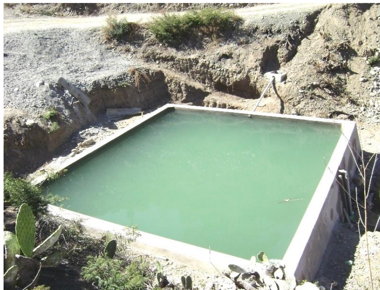
Figura 15. Obra de almacenamiento
