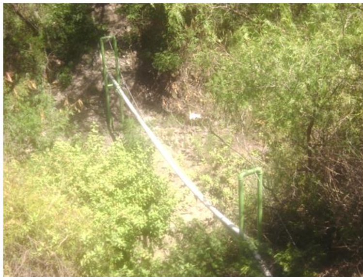
Figura 14. Paso de quebrada
