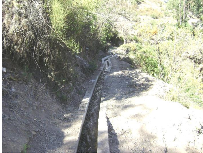
Figura 11. Obra de conducción
