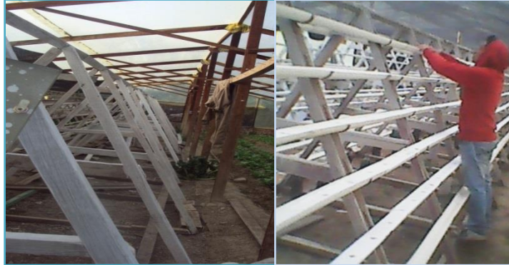
Armado de la estructura y revestimiento con plastoform
