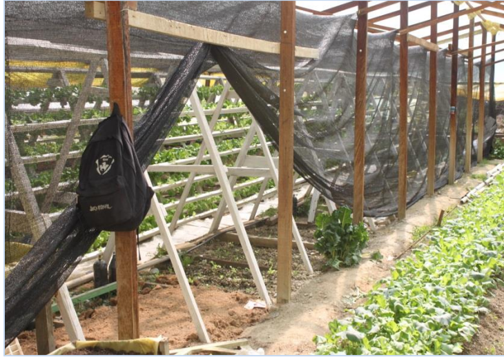
Instalación de la Semisombra
