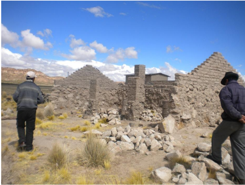
Construcción de un Nuevo Corral Dormidero
