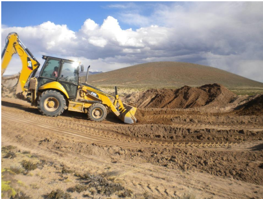
Apertura de Vigiña para almacenamiento de agua de Lluvia
