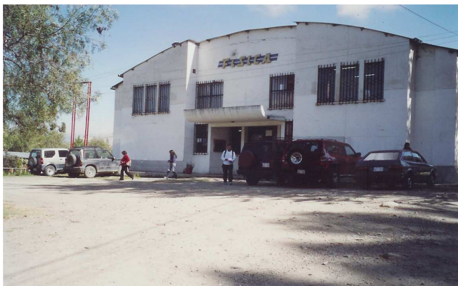
Fotografía 1 : Edificio de la Carrera de Física de la UMSA
