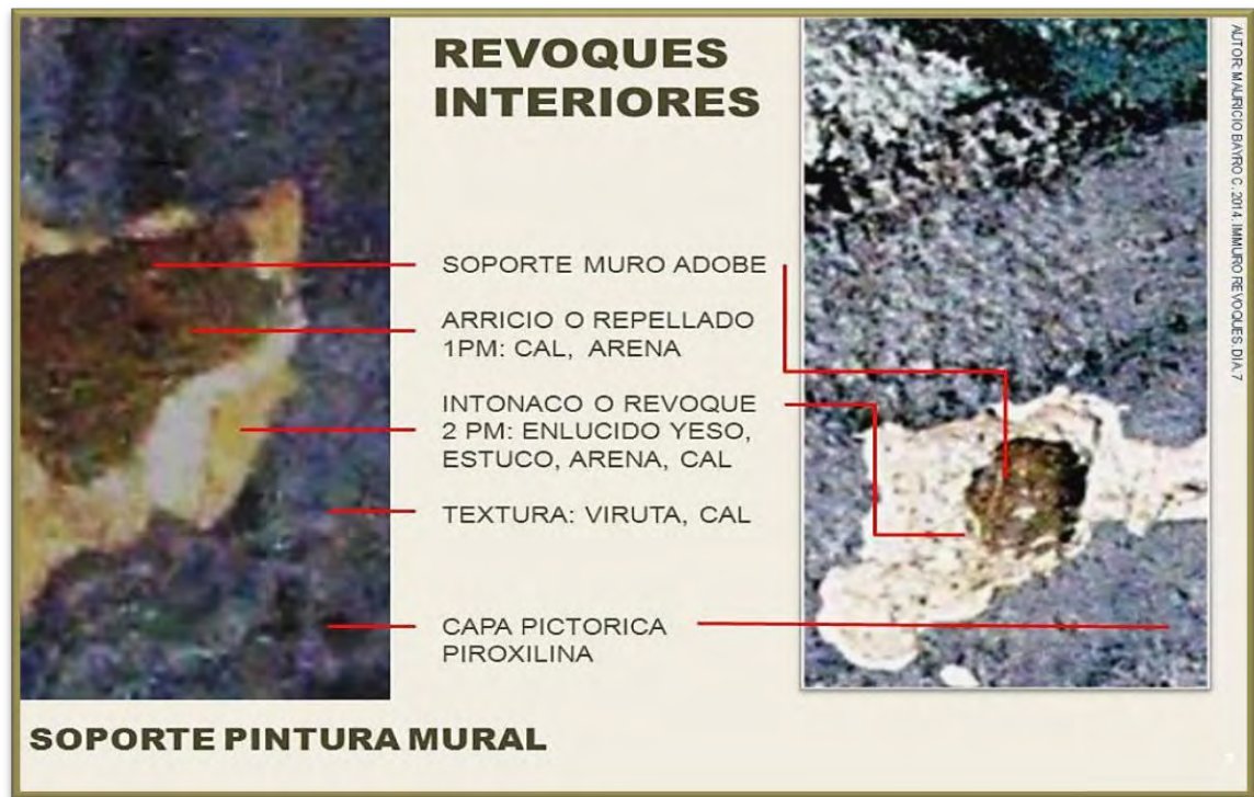
Ilustración 124. Muro soporte y revoque 1
