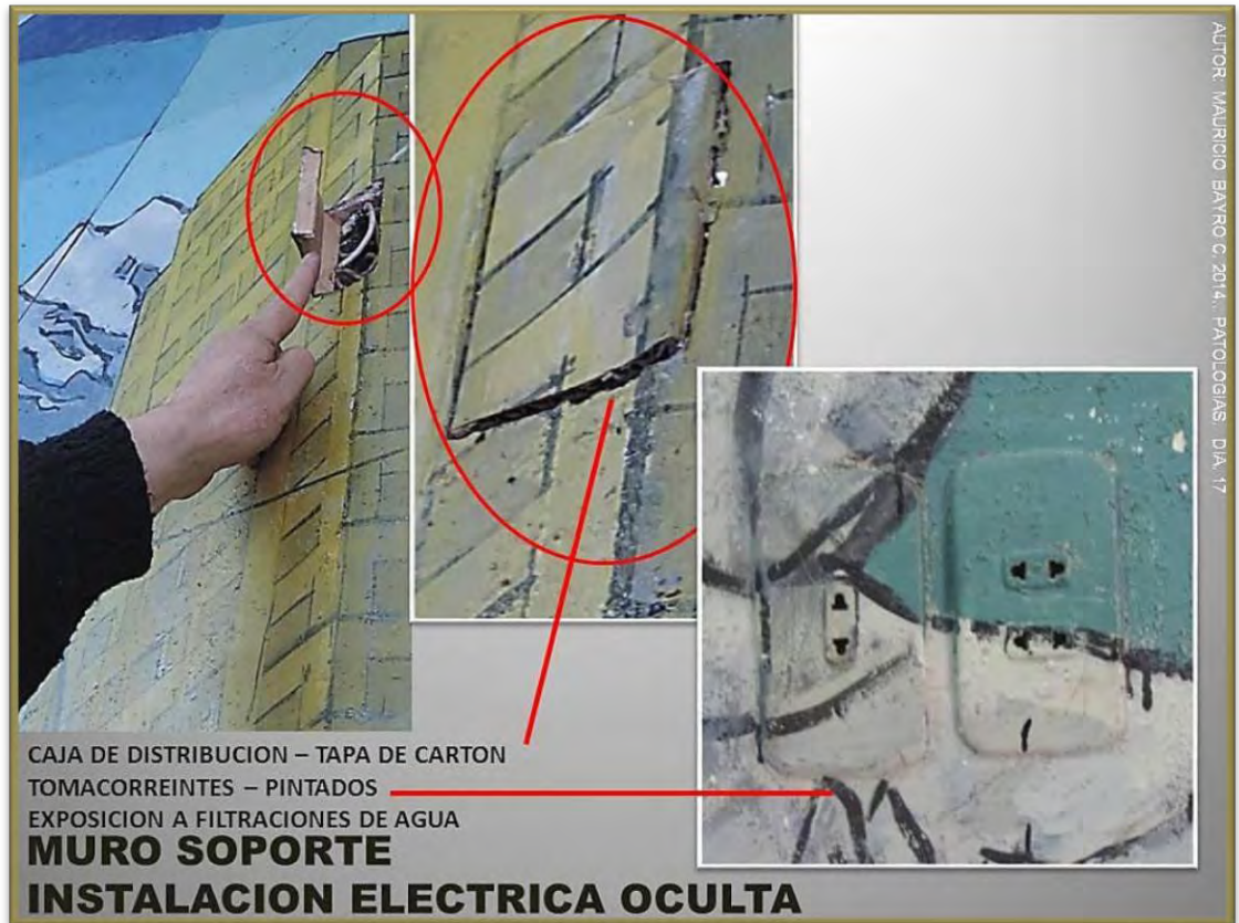
Ilustración 106. Instalación eléctrica. 1
