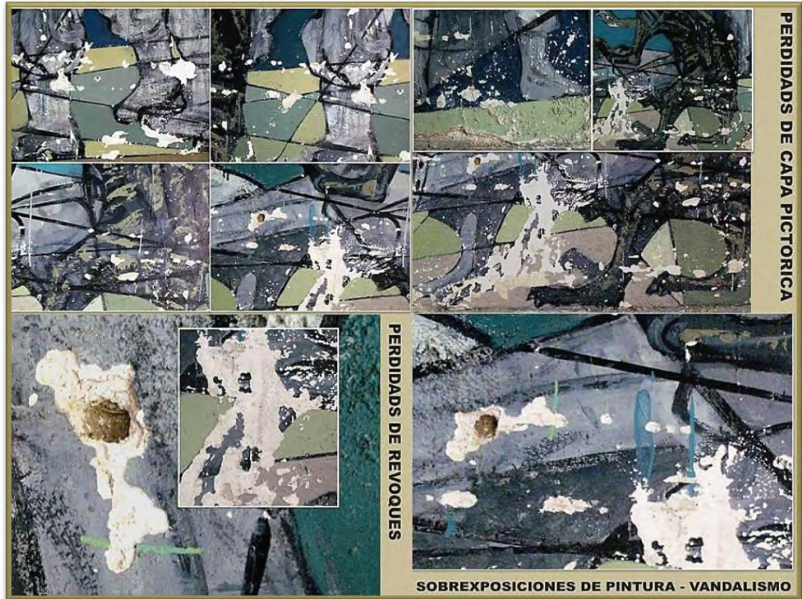
Ilustración 108. Perdidas de revoques e intonaco 1
