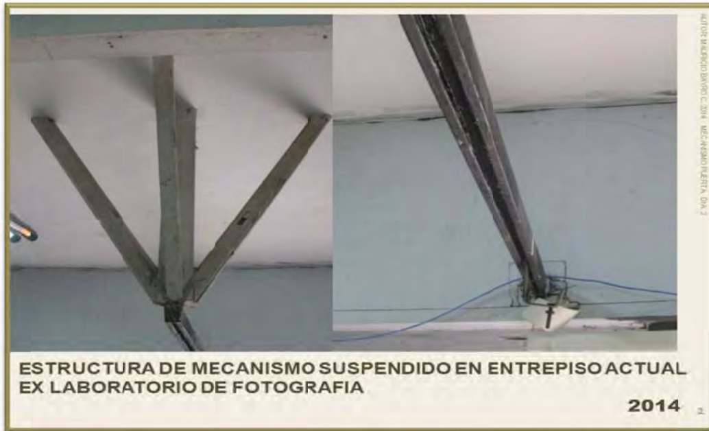
Ilustración A5. 3. Estructura suspendida.
