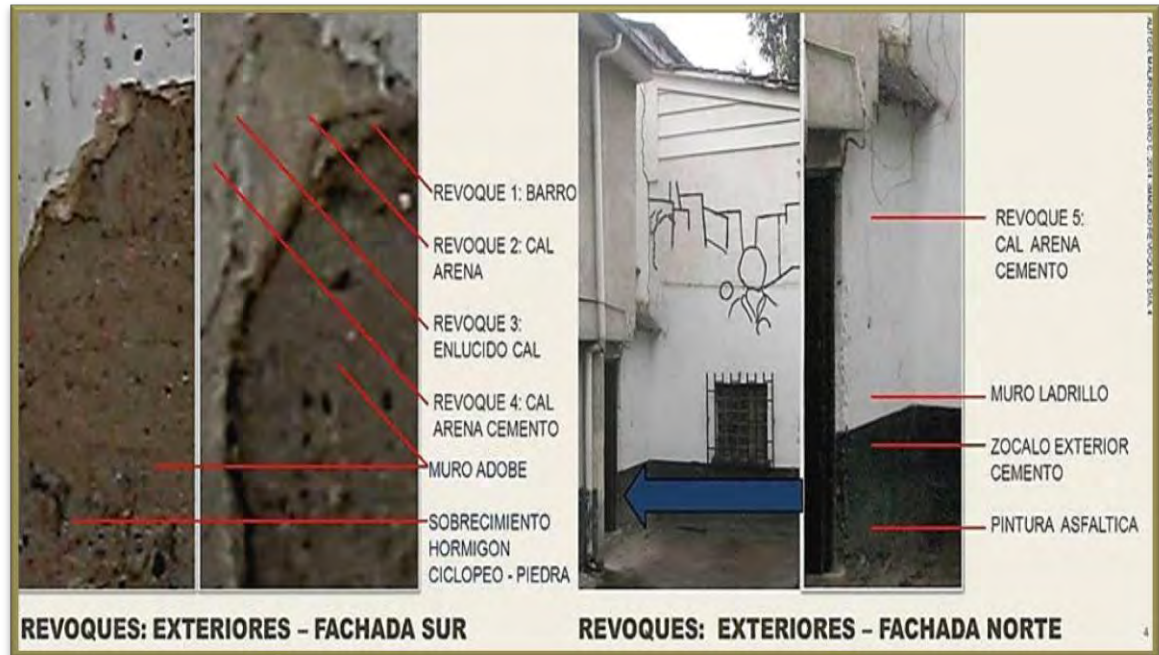
Ilustración 122. Fachadas sur y norte. Revoques exteriores. 1
