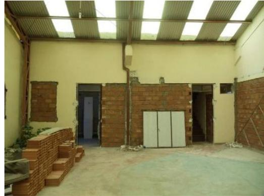
Se cubrió dos ventanas y una puerta con ladrillos de 6 huecos, se demolió un muro que se encontraba en forma diagonal, quedando dos puertas de acceso que eran necesarias a otras dependencias de la institución.
