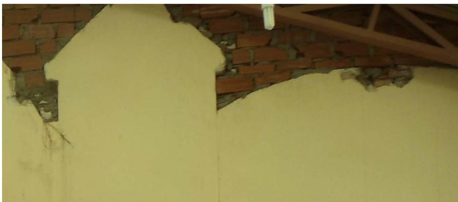
Se efectuó un revestimiento de cemento y cal al muro, con el apoyo de algunos concriptos y un albañil. Posteriormente se procedió a la aplicación del sellador de paredes. Una vez seco el material, se quitó las impurezas del soporte realizando un lijado y después de limpiar el polvo, se aplicó un impermeabilizante de interiores a base de agua. Finalmente se aplicó el color de base a los diferentes muros a intervenir.
