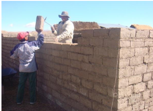
Foto: Laura, 2013 Fotografía 5. Construcción de Muros
