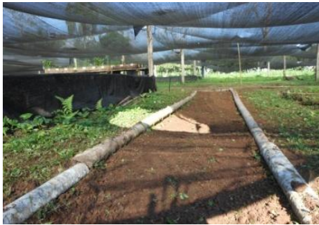
Construcción de la almaciguera
