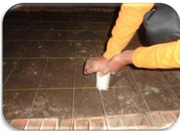
Fotografía N° 13: Extracción del suelo
