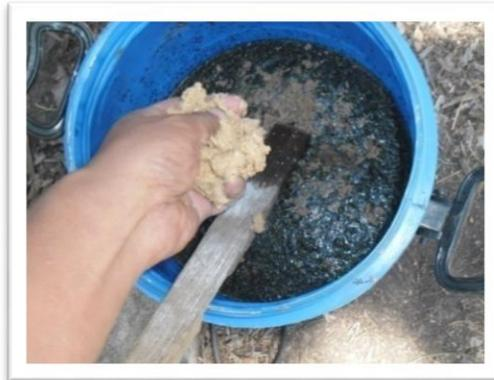
**Fotografía 5. Aplicación de la levadura de cerveza al biodigestor**
