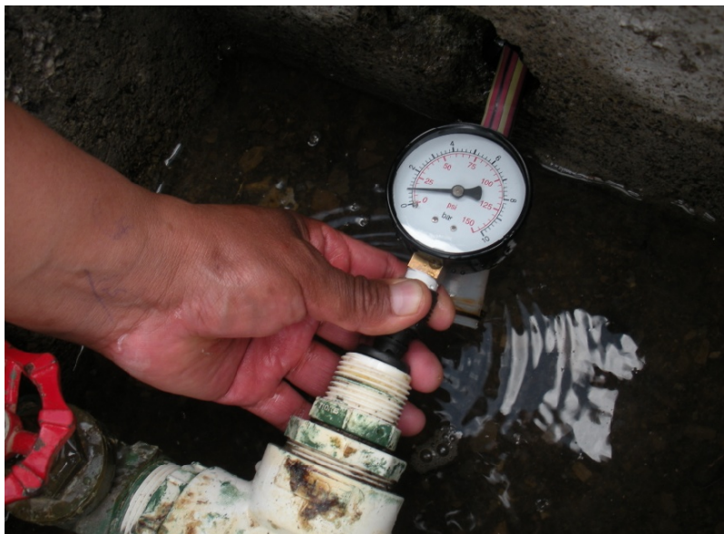
Fotografía 3. Medición de la presión en los hidrantes del sistema de conducción.
