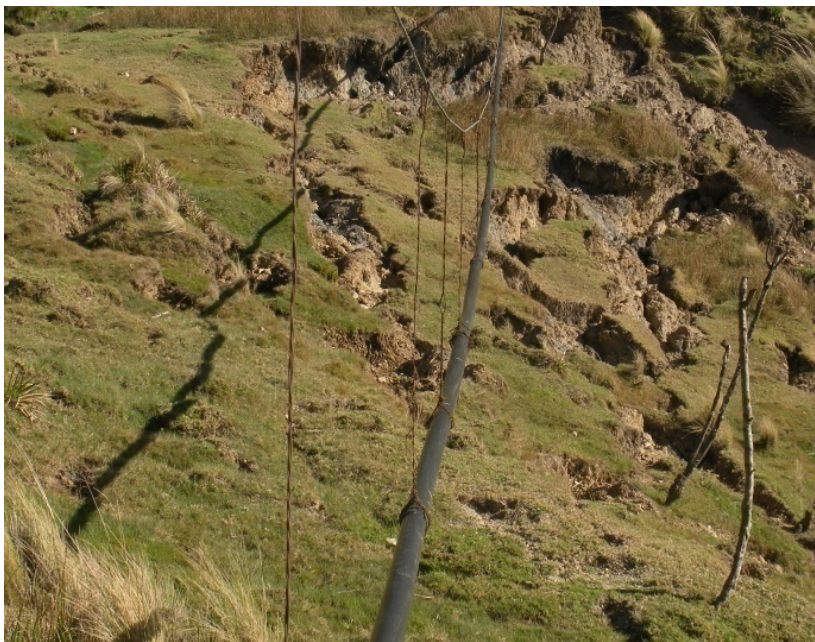
Fotografía 6. Sistemas de conducción a mediante tuberías de polietileno (politubo) por laderas en proceso de deslizamiento, Microriego Chiji
