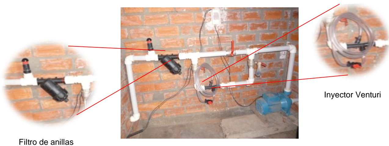
Figura 5. Cabezal de riego
