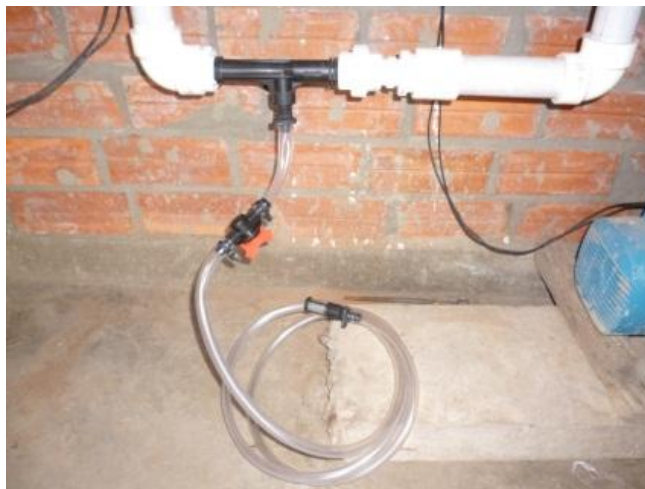
Figura 2. Inyector Venturi
