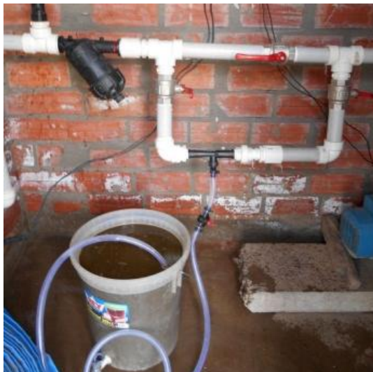
Figura 12. Incorporación de Biol al riego por inyector Venturi
