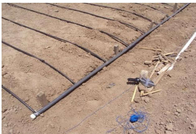
Figura 7. Conexión de los porta emisores a los laterales
