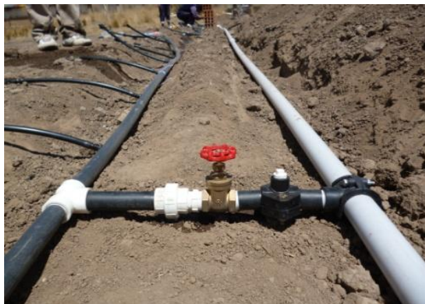
Figura 6. Instalación de los laterales
