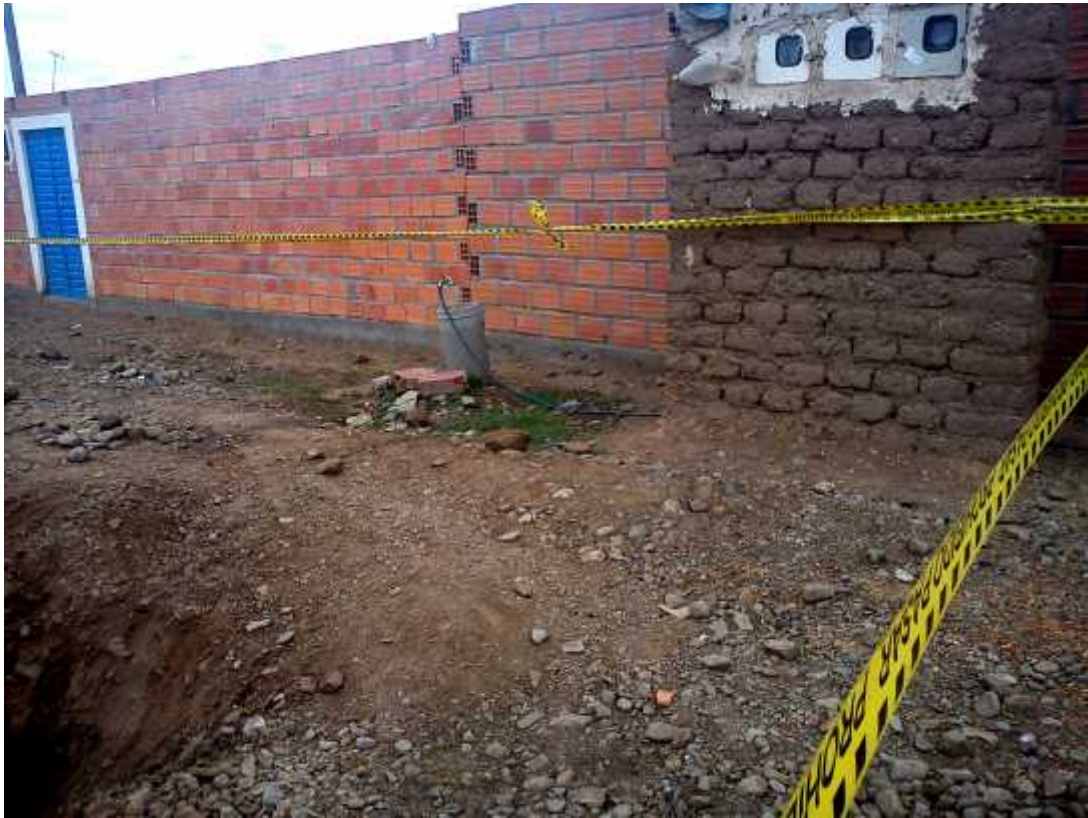
FOTO PILETA USADA POR VECINOS EN MEDIO DE OBRA DE INSTALACIÓN DE ALCANTARILLADO
