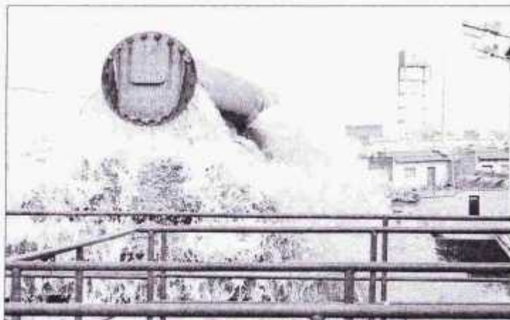
COBERTURA. En la foto, la planta de Tlata, cuya ampliación fue entregada el 30 de noviembre de este año.
