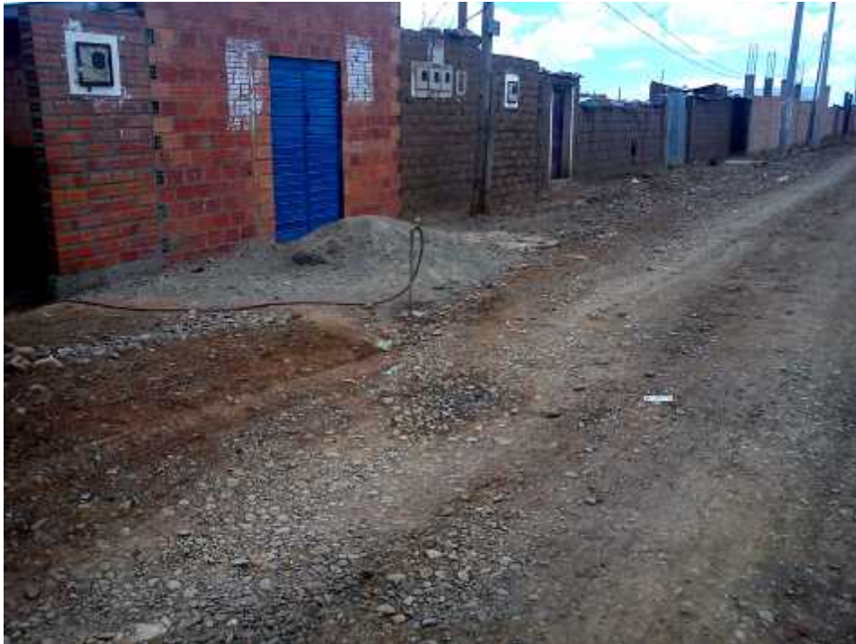
FOTO PILETA PÚBLICA USADA POR VECINO COMO PILETA DOMICILIARIA
