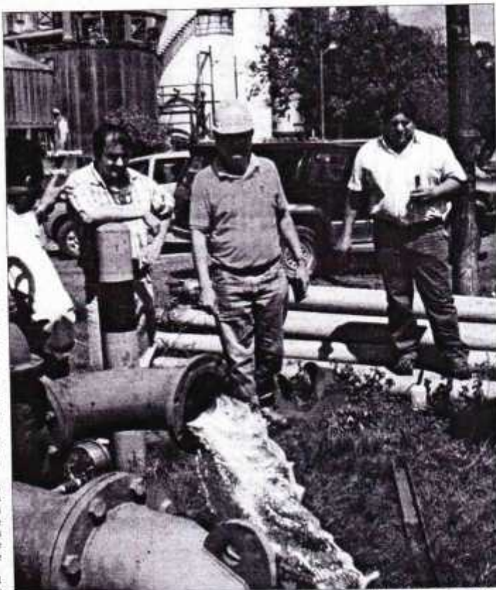
SANTA CRUZ. Una inspección de la AAPS a los gastos asociados verifica el cumplimiento de normas para pozos.
