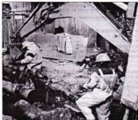
Se el cambio de tuberías principales de agua potable. Los casos de emergencia persisten.
