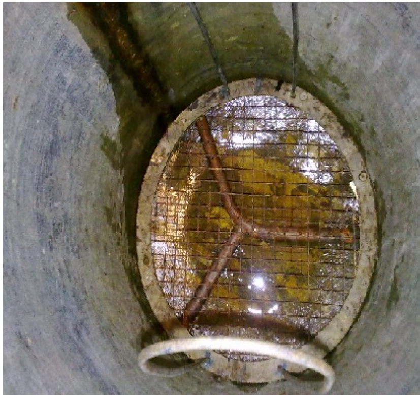
Figura 14: Distribuidor de vapor
