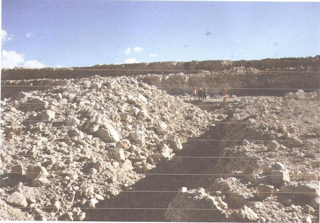
Voladura efectuada en Cantera a cielo abierto
