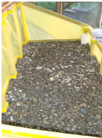
Figuras 9 y 10. (de izq. a der.) Se observa el tercer estrato (grava), en el cual se observa en el fondo el tubo de plástico (de 4 pulgadas de diámetro) donde se introducirá el agua a la cámara de sub-irrigación,
