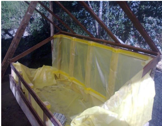
Figuras 4 y 5. (de izq. a der.) Forrado de la cámara de sub-irrigación con nylon mica.
