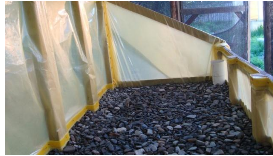
Figuras 9 y 10. (de izq. a der.) Se observa el tercer estrato (grava), en el cual se observa en el fondo el tubo de plástico (de 4 pulgadas de diámetro) donde se introducirá el agua a la cámara de sub-irrigación,
