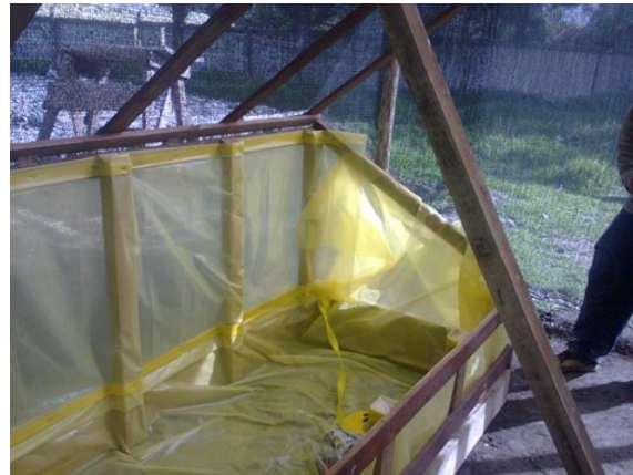
Figuras 4 y 5. (de izq. a der.) Forrado de la cámara de sub-irrigación con nylon mica.
