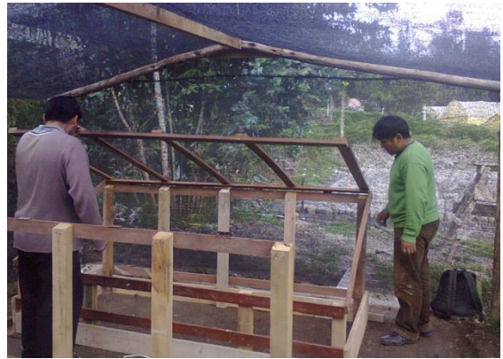
Figuras 2 y 3. (de izq. a der.) Instalación de la cámara de sub-irrigación
