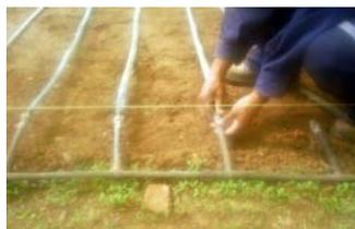
Figura 24. Instalación sistema de riego.
