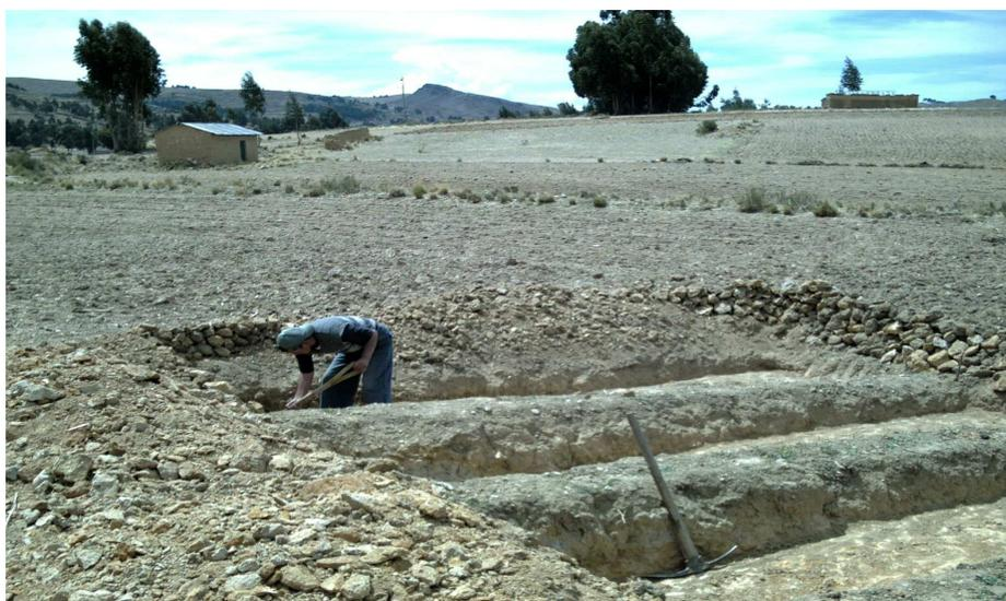
**Figura. 2 Apertura de zanjas**
