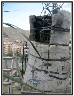
Una vez retirado el encofrado se procedió al alisado de la obra, primero con cemento puro diluido, luego se utilizó lija flexible de metal.
