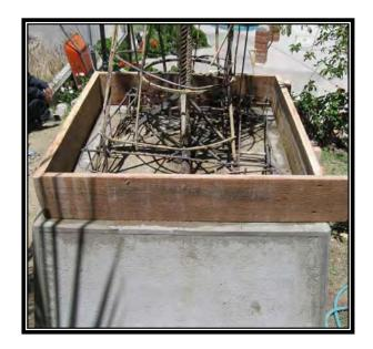
Vaciado de la base en el pedestal
