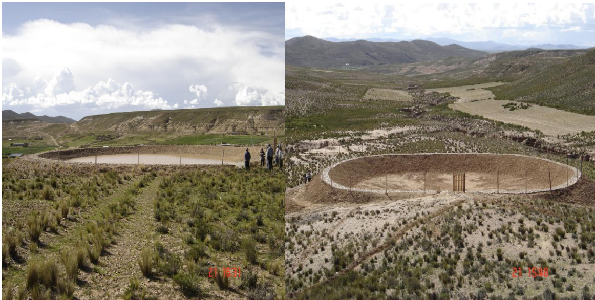
Fig. 7 En la primera fotografías se observa un atajado o qotaña con agua la cual esta lista para su uso. La segunda fotografía nos muestra un atajado o qotaña recién terminado, en el podemos observar la construcción de la misma.
