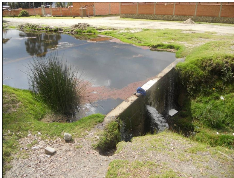
Fotografía N° 3: Presa actual en funcionamiento
