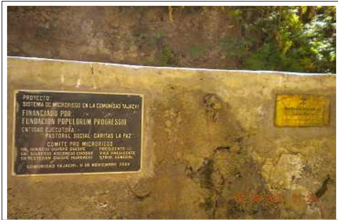
Foto N° 21 El muro principal del estanque de agua del sistema de micro-riego, muestra las placas que recuerdan a las Instituciones que hicieron posible la obra de riego en Yajachi.
