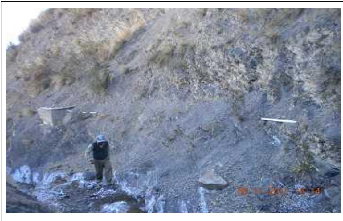
Foto N° 20. Un tramo de la obra de riego, donde se observa al fondo la cámara desarenadora del sistema de aducción.
