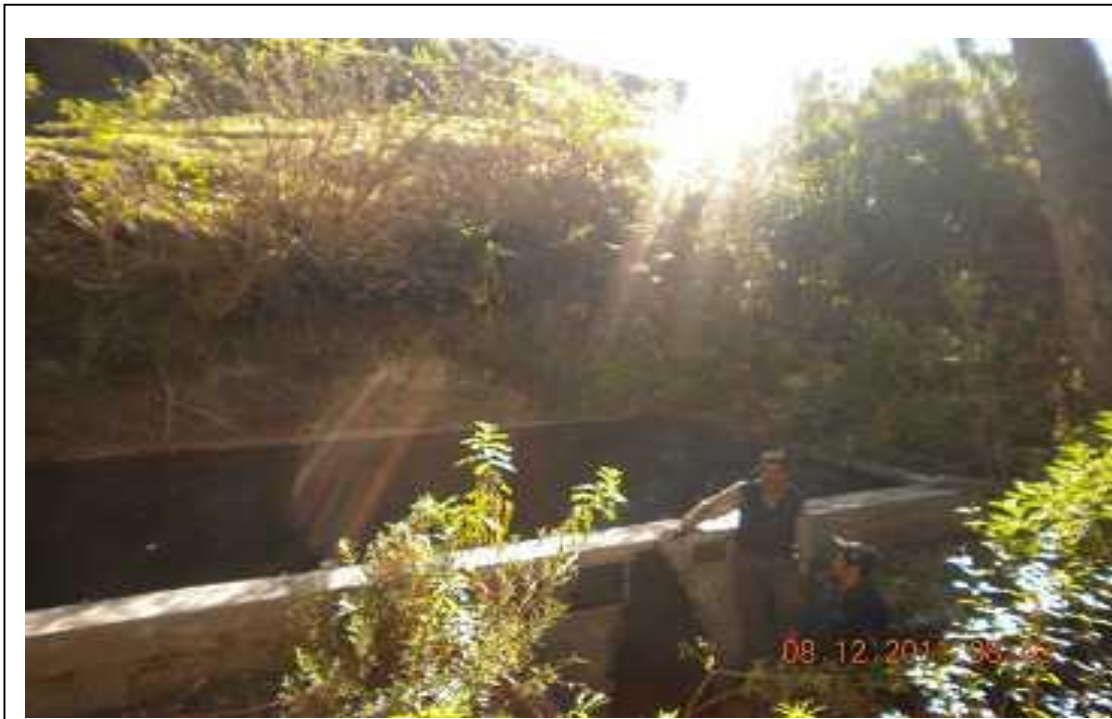
Foto N° 17. El Secretario General de Yajachi, explica las razones por las que el desagüe fue anulado en el tanque de almacenamiento de agua del sistema de micro-riego.
