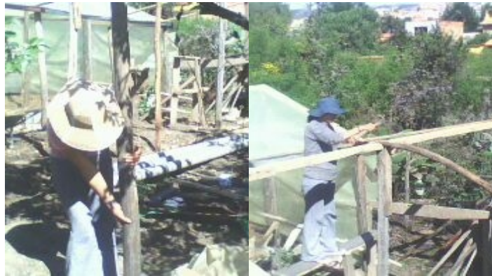
Figura 2. Construcción de la carpa solar.
