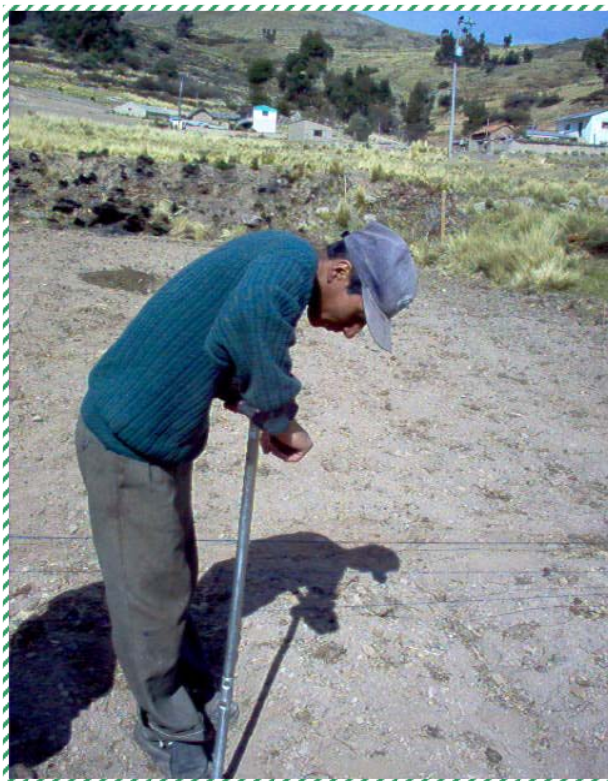
Perforación del suelo
