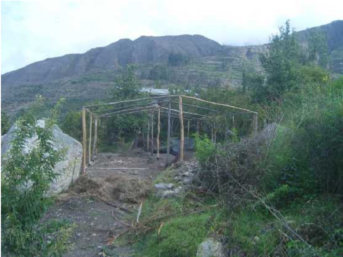
Figura 5. 1 Construcción del vivero en la comunidad de Torreopampa
