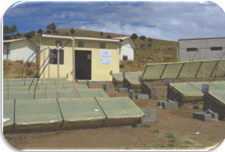
Figura N°8: Biodigestores Instalados en el Centro Experimental de Choquenaira
