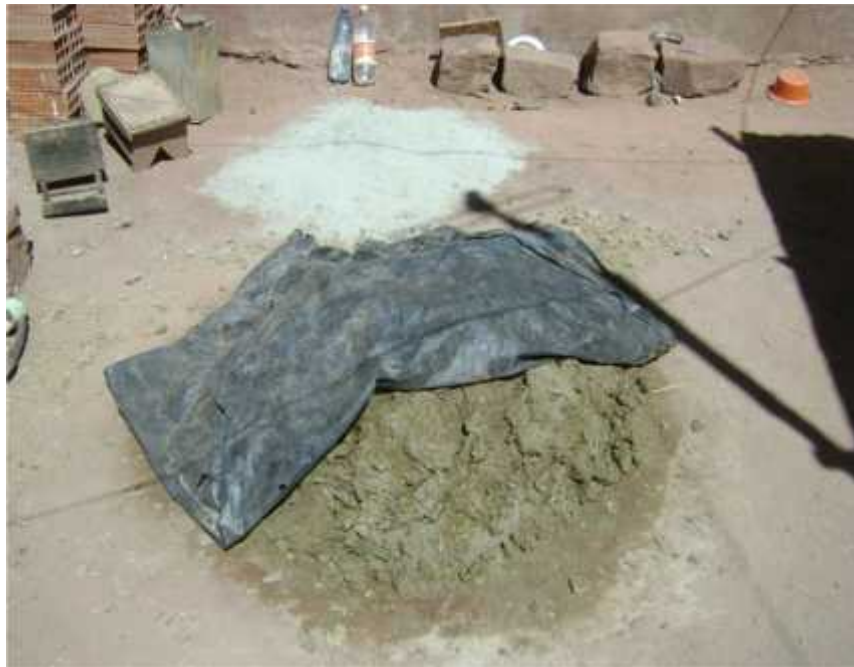
Imagen 7: Barro macerado para la construcción de la cocina Lorena
