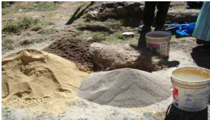
Imagen 6: Materiales para barro de la cocina Lorena
