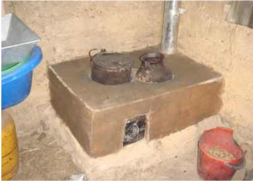
Imagen 11: Cocina Lorena terminada
