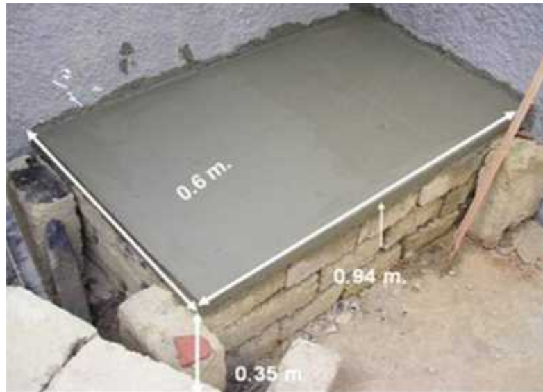
Imagen 8: Dimensiones de la plataforma para la construcción
