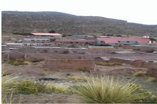
IMAGEN N°20: CÁRCEL DE COROCORO EN CONDICIÓN PRECARIA
