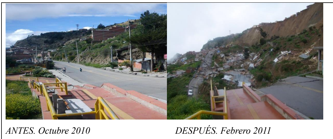
Figura 3.24. Vista Panorámica sector afectado. Deslizamiento Complejo Pampahasi-Callapa
