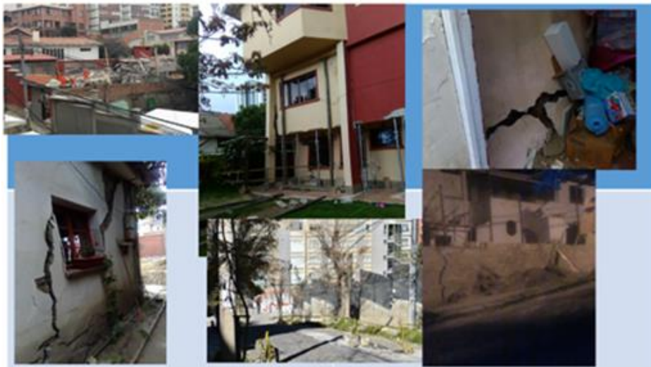
Figura 3.47. Viviendas colapsadas calles 4 y Residencia Británica calle 5.
