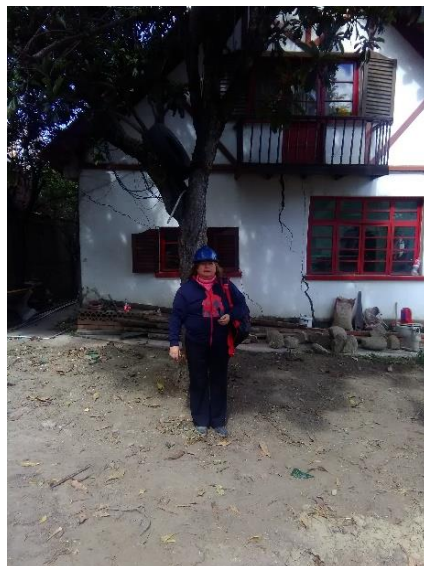
Figura 3.44. Inspección a casa colapsada calle 4, mayo 2018. Maria Otero
