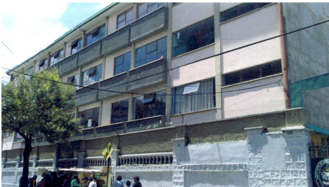
Vista externa del Instituto
