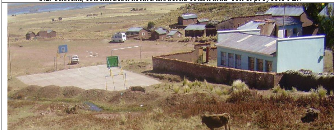
U.E. Taypi Chiviraya construcción de 1952 con muros de adobe y polifuncional
