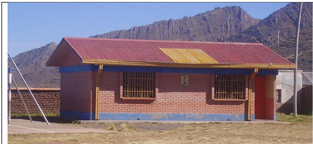
U.E. Okorani, con infraestructura moderna construida con el proyecto PEN
