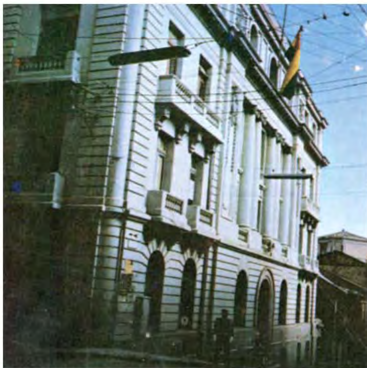
Edificio en el que la CGR ejercía el Control Gubernamental desde su creación hasta 1976.
