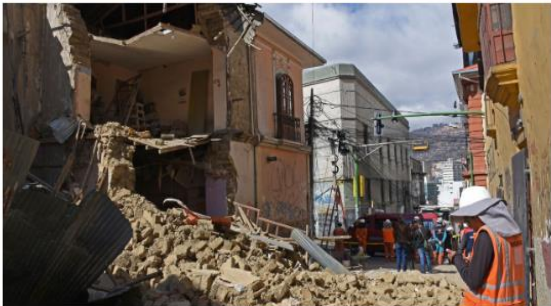
El desplome afectó el tránsito vehicular en el centro paceño y miraflores.
