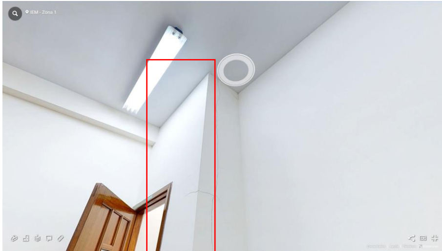
Fotografía 39 Lab. Química – Asfaltos (Fisuras)
