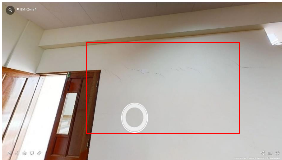
Fotografía 106 Sala de docentes Hormigones y Estructuras (Fisuras)
