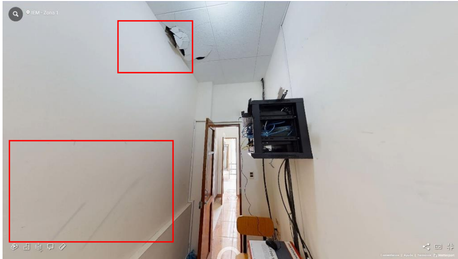
Fotografía 112 Sala Shaft (Fisuras y techo falso en mal estado)
