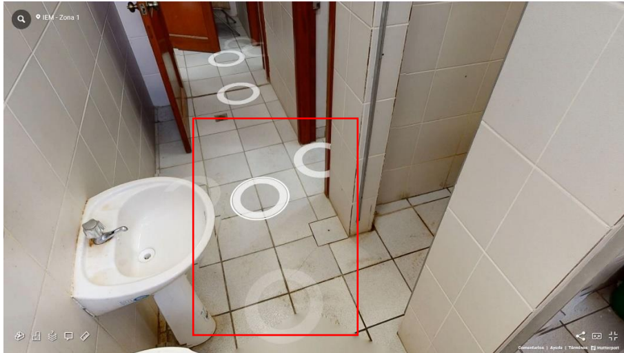
Fotografía 9 Baño 4.1 (Lavamanos deteriorado, piso en mal estado)
