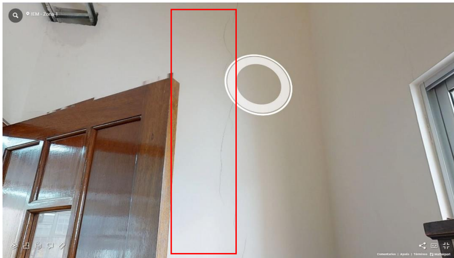
Fotografía 23 Lab. Asfaltos (Fisuras)
