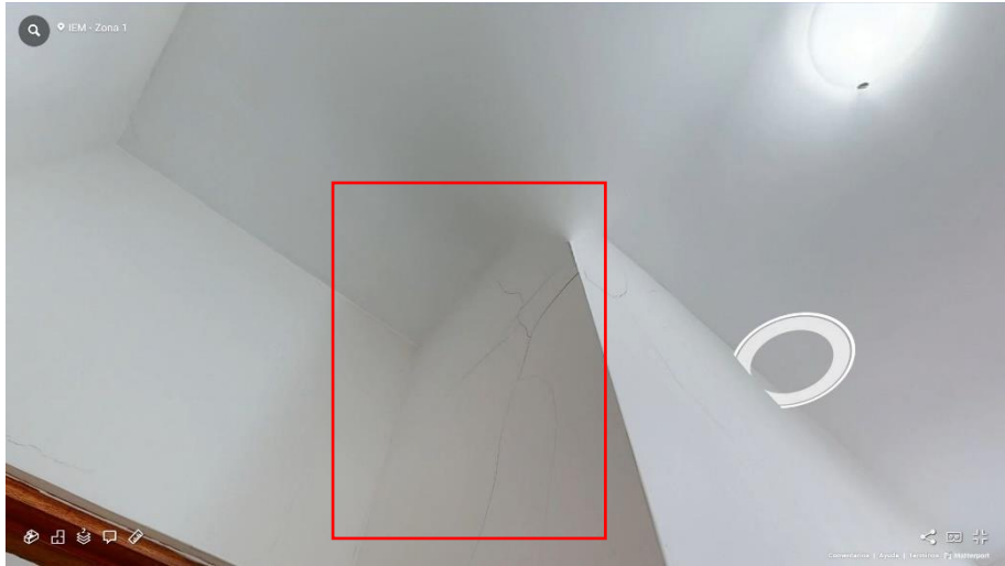
Fotografía 3 Baño 1.2 (Fisuras)
