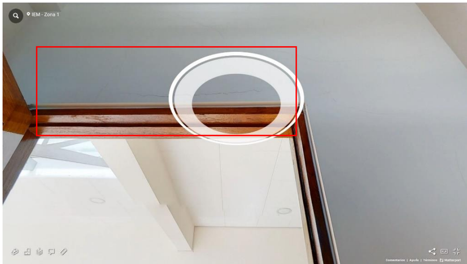
Fotografía 65 Baño 3 (Fisuras)
