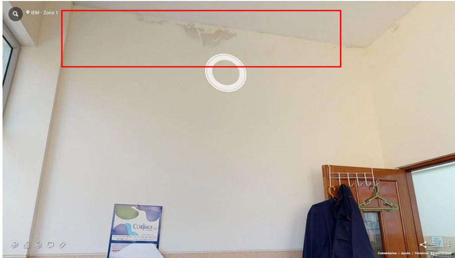
Fotografía 41 Sala de Corte de Probetas (Humedad en la Pared)
