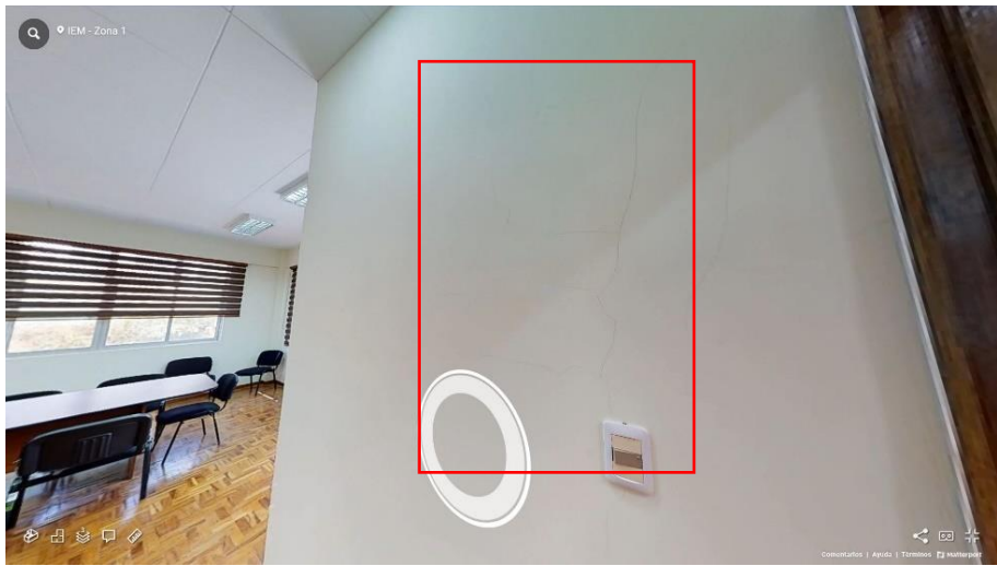
Fotografía 100 Sala de Control 9 (Fisuras)
