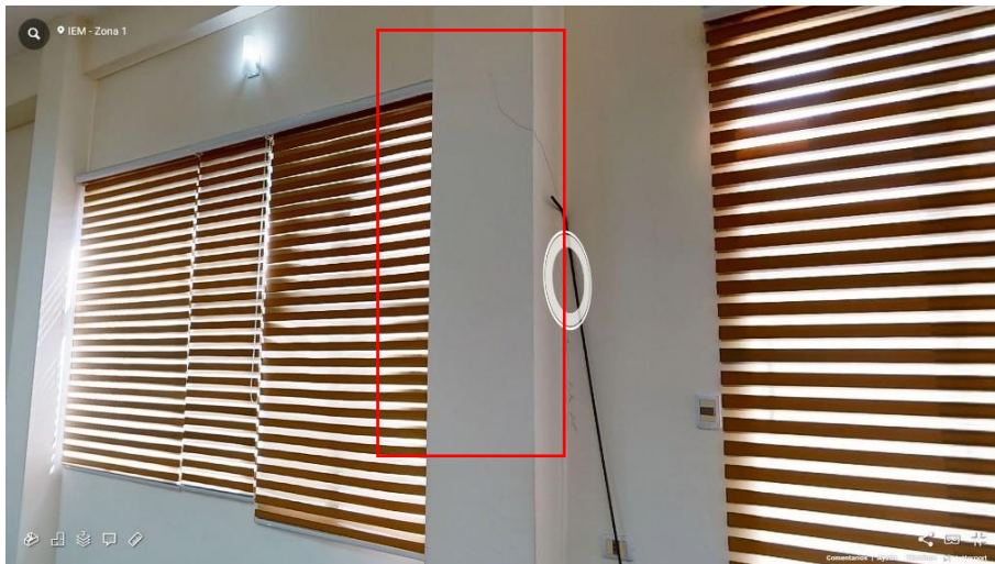
Fotografía 53 Auditorio (Humedad a causa de una gotera)
