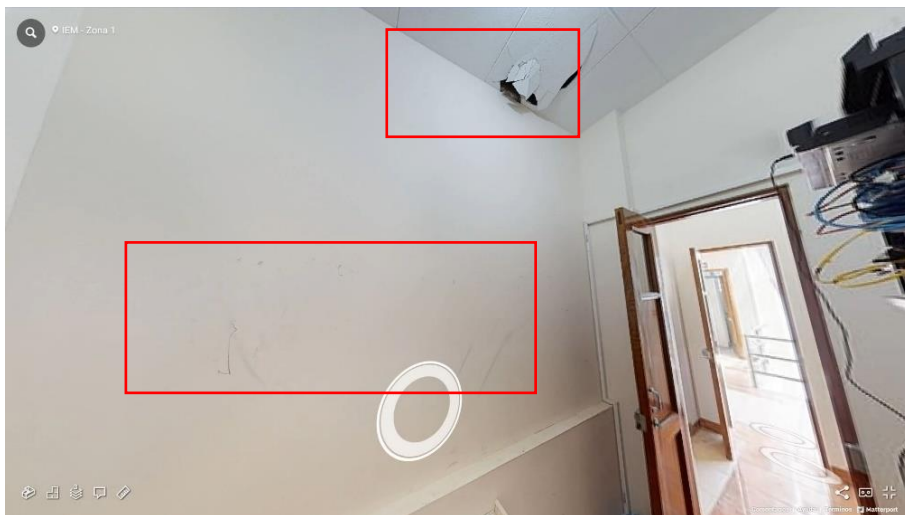
Fotografía 110 Sala Shaft (Fisuras)
