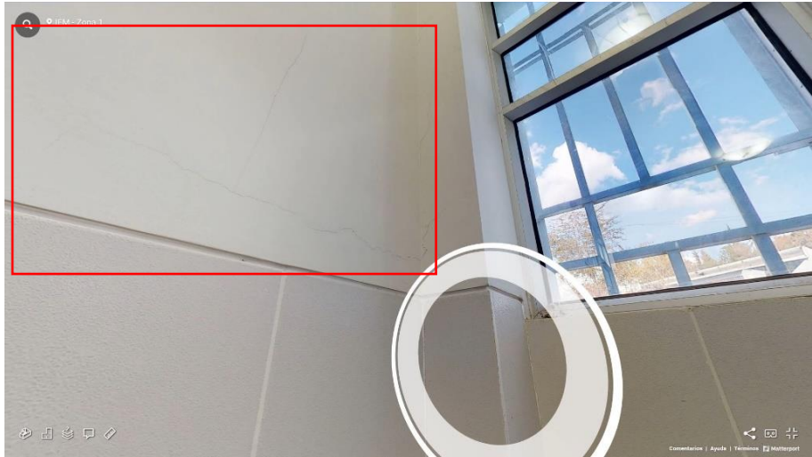
Fotografía 5 Baño 3.2 (Fisuras)
