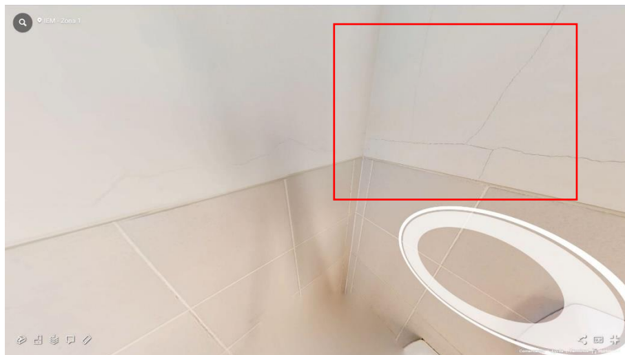
Fotografía 61 Baño 2 (Fisuras)
