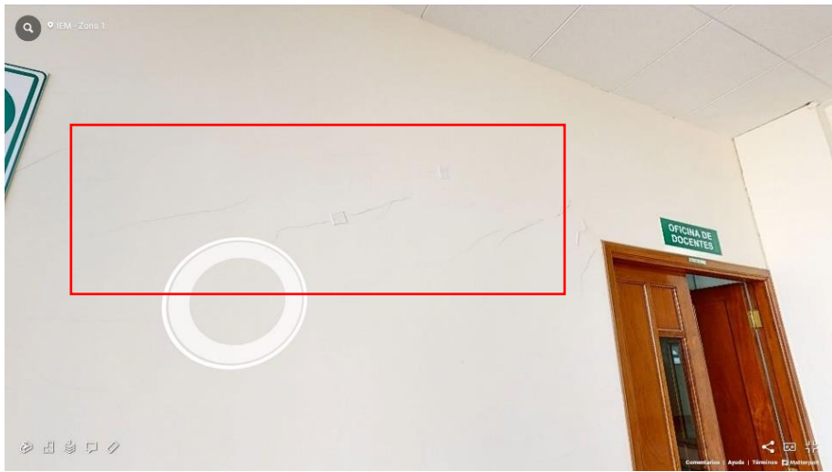
Fotografía 84 Hall (Fisuras en viga)
