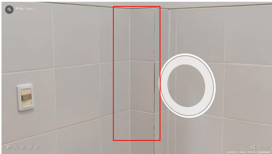
Fotografía 70 Baño 5 (Uniones Azulejos)
