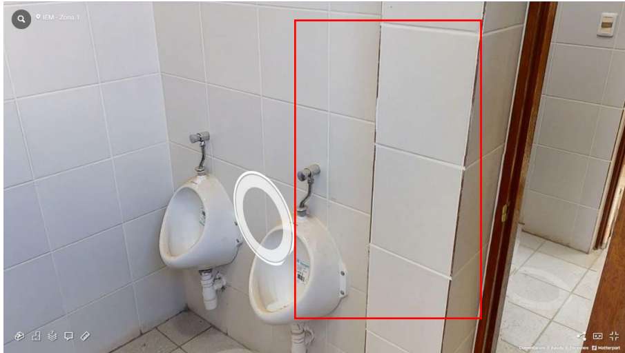
Fotografía 7 Baño 3.4 (Uniones de azulejos deteriorados)
