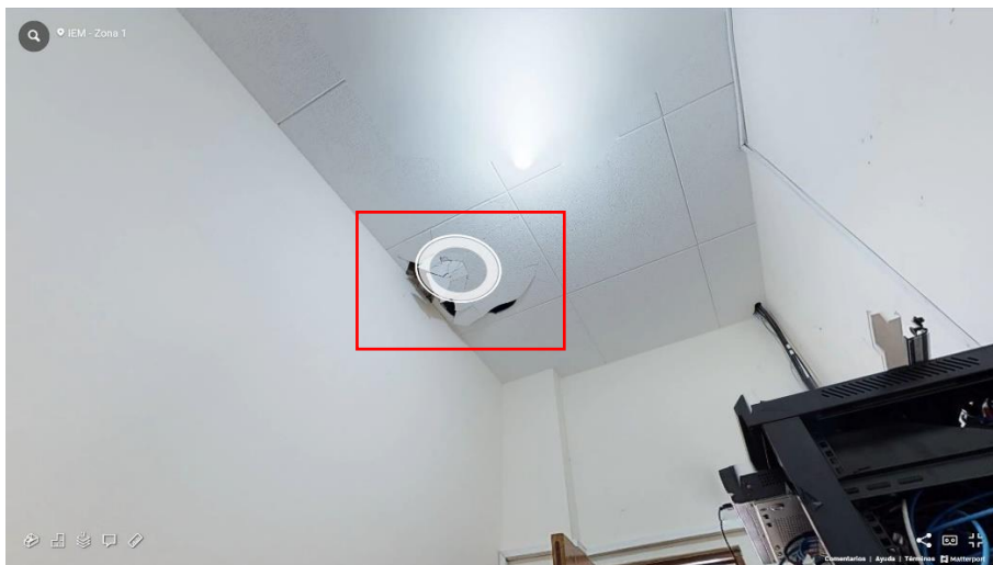
Fotografía 112 Sala Shaft (Fisuras y techo falso en mal estado)
