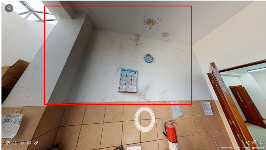
Fotografía 27 Lab. Asfaltos 2 (Pared Manchada)
