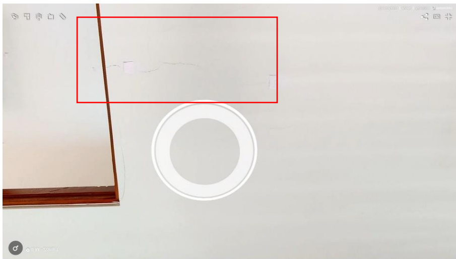
Fotografía 82 Deposito 12c (Fisuras)
