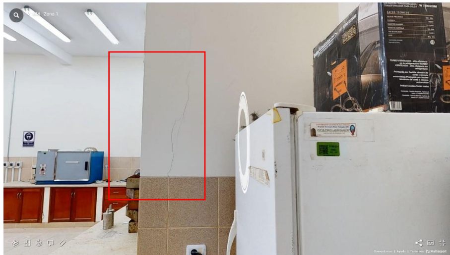
Fotografía 35 Lab. de Materiales y Servicios (Humedad en la pared y Fisuras)
