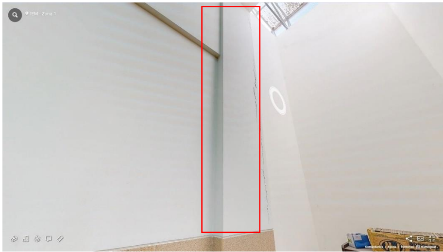
Fotografía 17 Escaleras (Fisuras)
