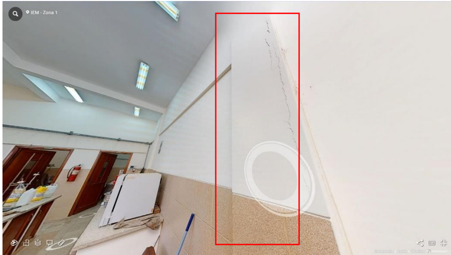
Fotografía 19 Lab. Química (Fisura de Columnas)
