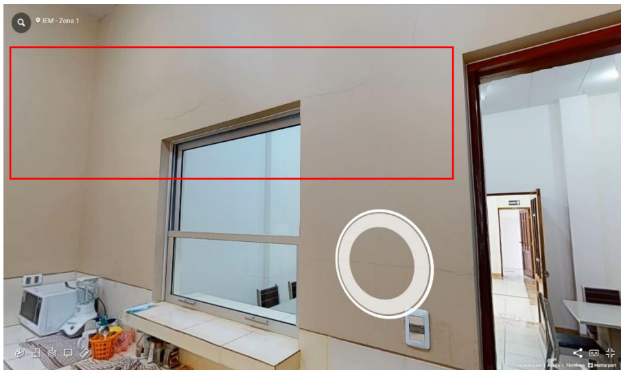
Fotografía 76 Cocina (Fisuras)
