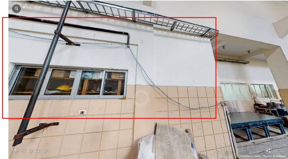
Fotografía 45 Tinglado Hormigón y vaciado (Sistema eléctrico al aire)
