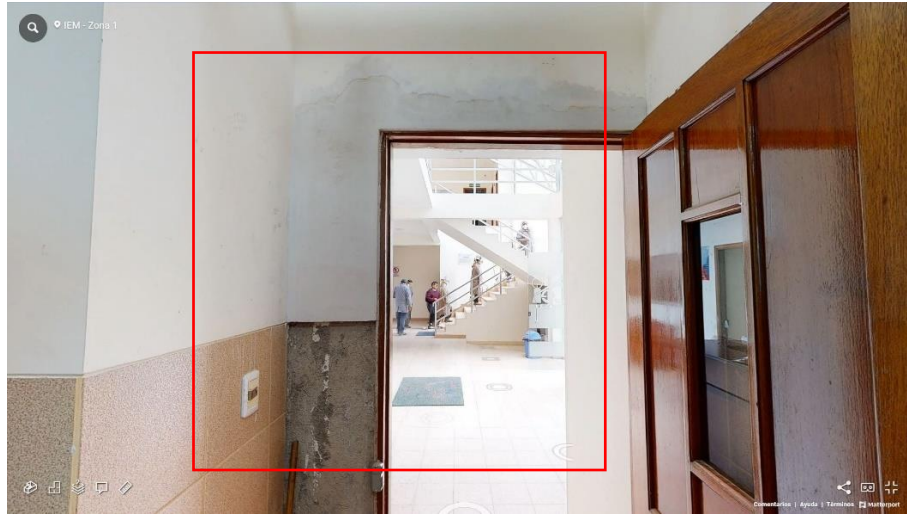
Fotografía 25 Lab. Asfaltos (Muro de Puerta sin azulejos y deteriorada)
