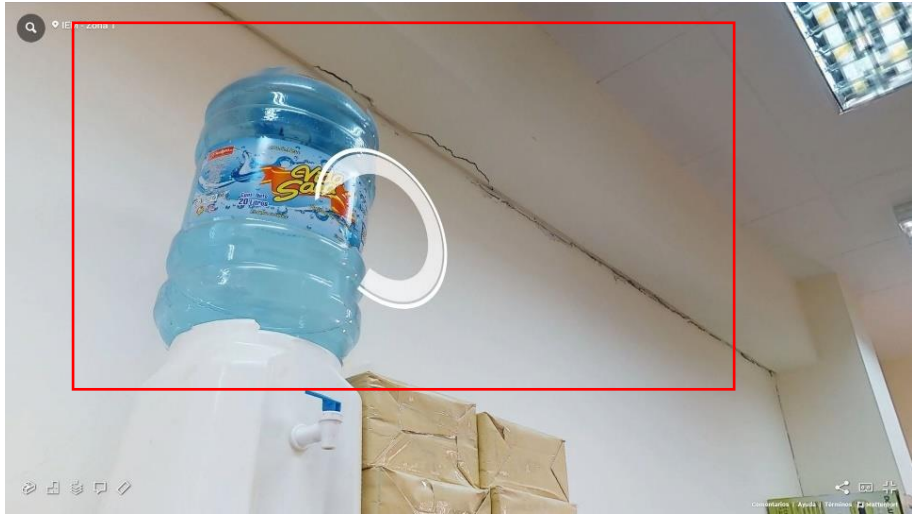
Fotografía 84 Hall (Fisuras en viga)
