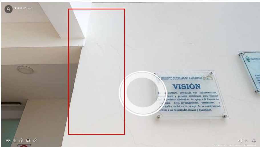
Fotografía 15 Ducha 1 (Fisura Pared)
