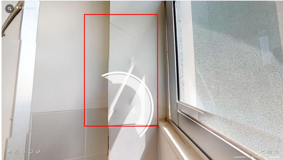
Fotografía 63 Baño 2 (Fisuras)
