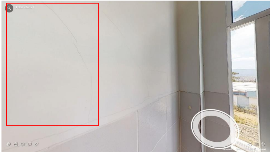
Fotografía 59 Baño Dirección (Fisuras)
