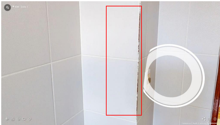
Fotografía 67 Baño 3 (Fisuras)
