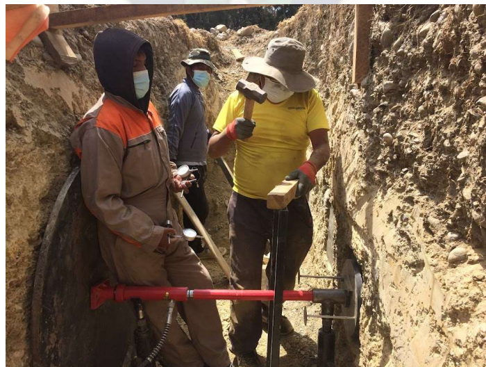
Fotografía 32. Colocado de bastidor para los extensómetros.
