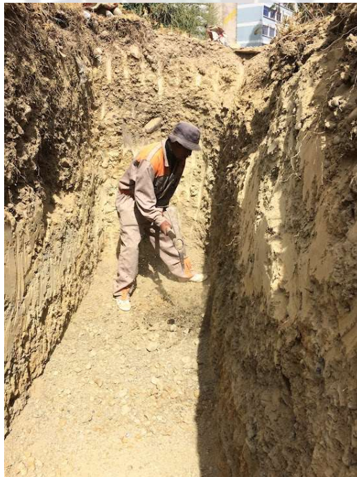
Fotografía 22. Se ha perfilado de manera manual la zanja. Fuente: Elaboración propia
