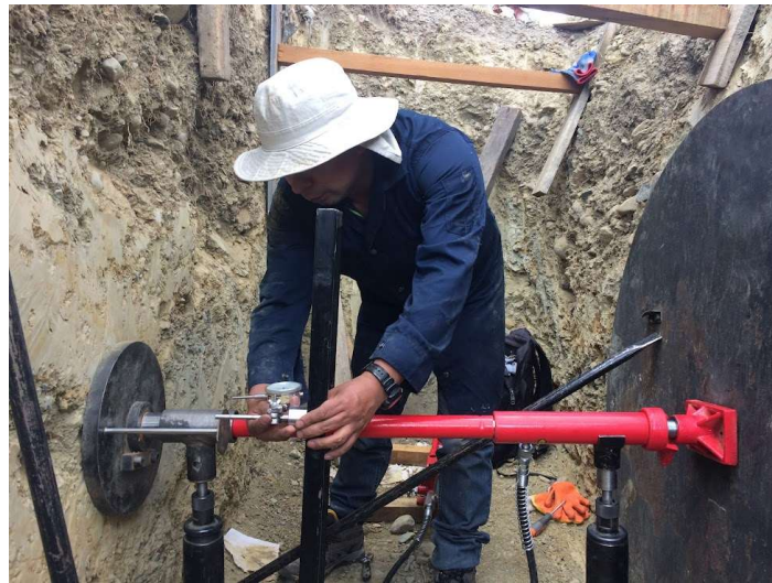
Fotografía 33. Instalación de los extensómetros. Fuente: Elaboración propia
