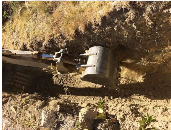
Fotografía 4. Excavación de la zanja para el ensayo.
