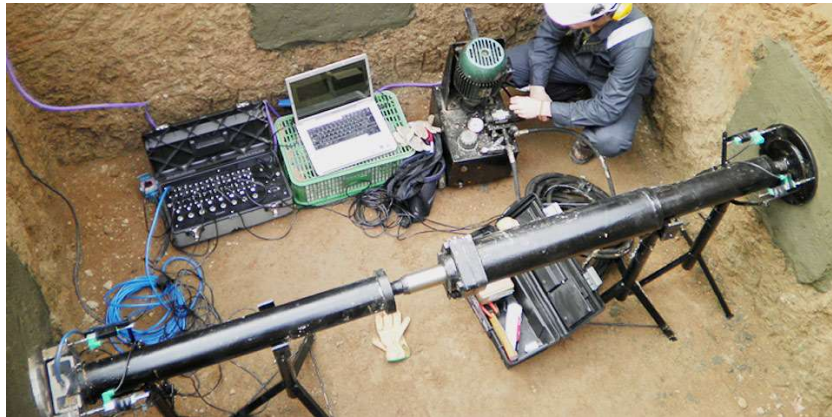
Fotografía 3. Ejecución del ensayo de carga horizontal.
