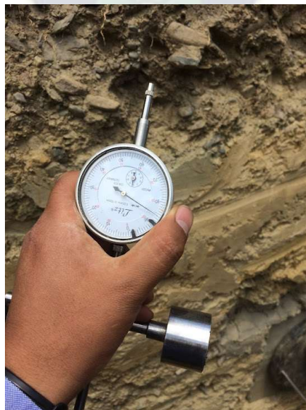
Fotografía 30. Se verifica el buen estado de los extensómetros.
