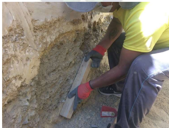
Fotografía 24. Se procuró asegurar la verticalidad del terreno. Fuente: Elaboración propia
