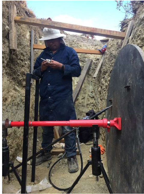
Fotografía 29. Armado preliminar del equipo.
