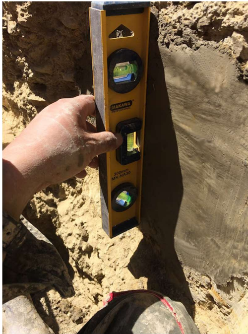
Fotografía 27. Verificación de la verticalidad del revoque. Fuente: Elaboración propia
