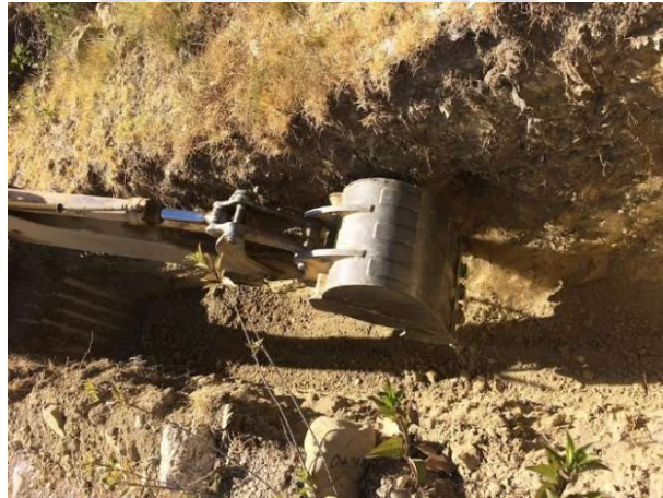
Fotografía 20. Se procuró que la zanja sea ancho reducido. Fuente: Elaboración propia
