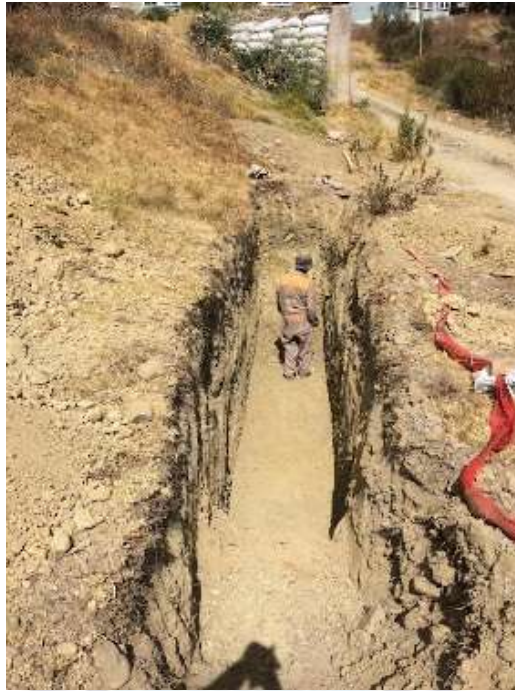
Fotografía 21. Se han evaluado los sectores del talud que no estaban verticales. Fuente: Elaboración propia
