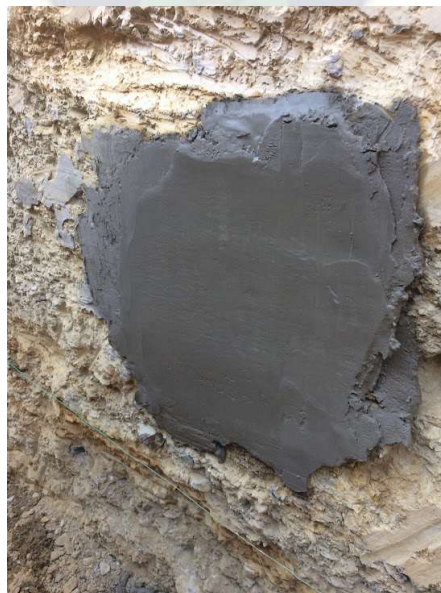
Fotografía 26. Mortero aplicado en el terreno. Fuente: Elaboración propia
