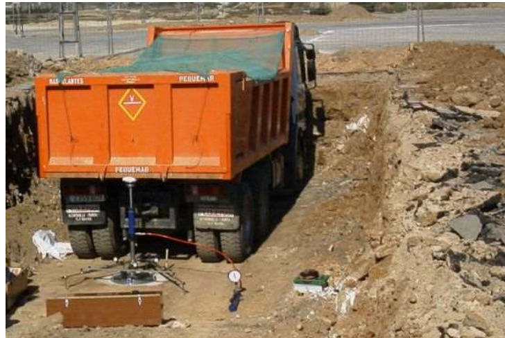
Fotografía 1. Ejecución del ensayo de placa en superficie.
