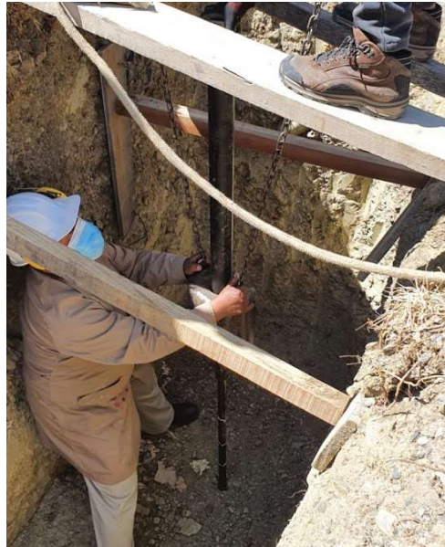
Fotografía 36. Ejecución del ensayo SPT. Fuente: Elaboración propia
