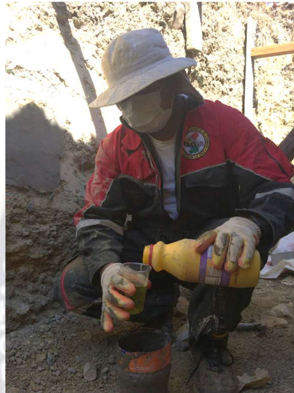
Fotografía 25. Empleo de Sika 3 para la fabricación del mortero. Fuente: Elaboración propia
