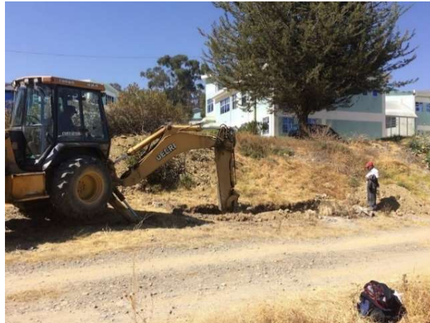
Fotografía 19. Excavación de zanja con retroexcavadora. Fuente: Elaboración propia
