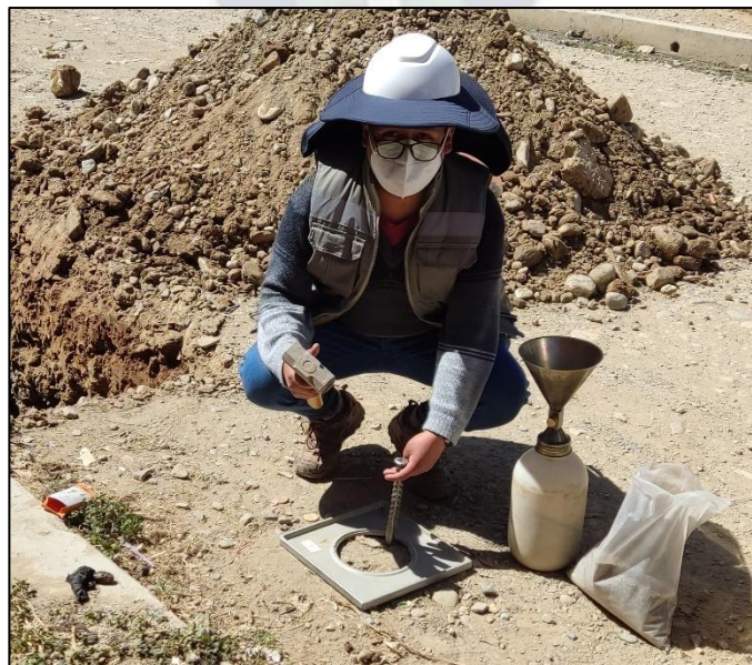
FOTOGRAFIA 10. ELABORACION DEL ENSAYO DE DENSIDAD MÉTODO CONO DE ARENA
