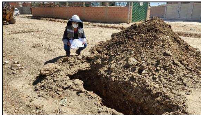
FOTOGRAFIA 4. TERMINADO DE EXCAVACIÓN MAQUINARIA
