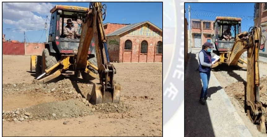
FOTOGRAFIA 3. PROCESO DE EXCAVACIÓN CON MAQUINARIA
