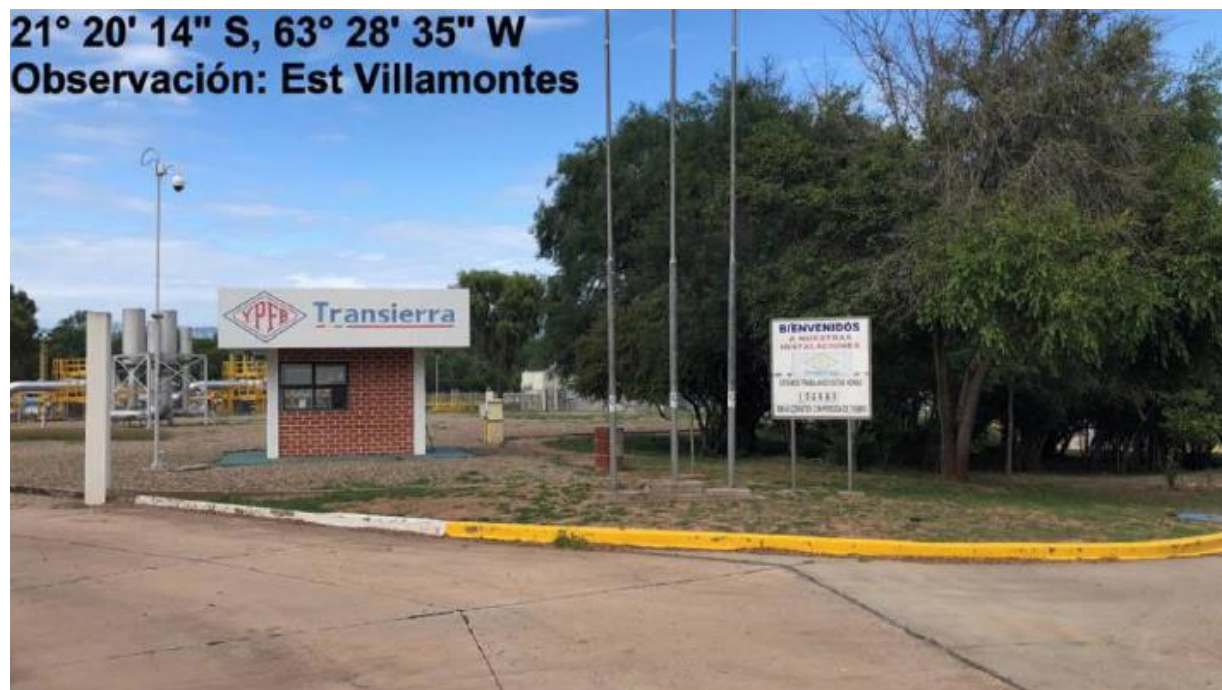
Estación de control y medición “VILLAMONTES”
