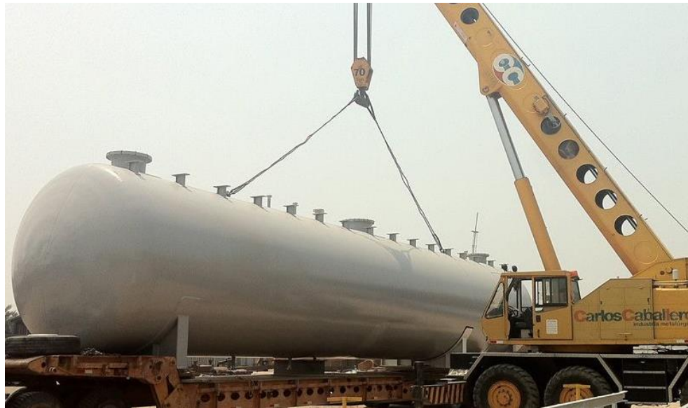
Figura 2.13 Izaje de un tanque horizontal a presión
