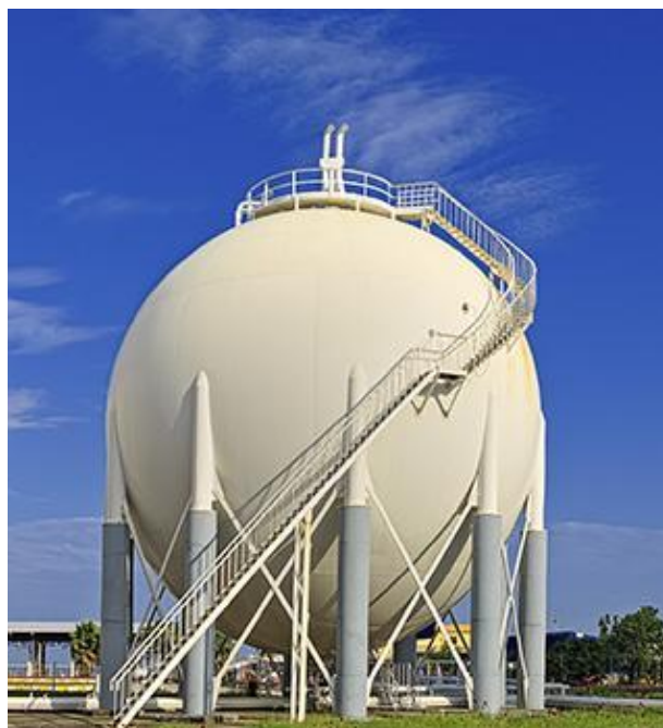
Figura 2.3 Tanque a presión esférico
