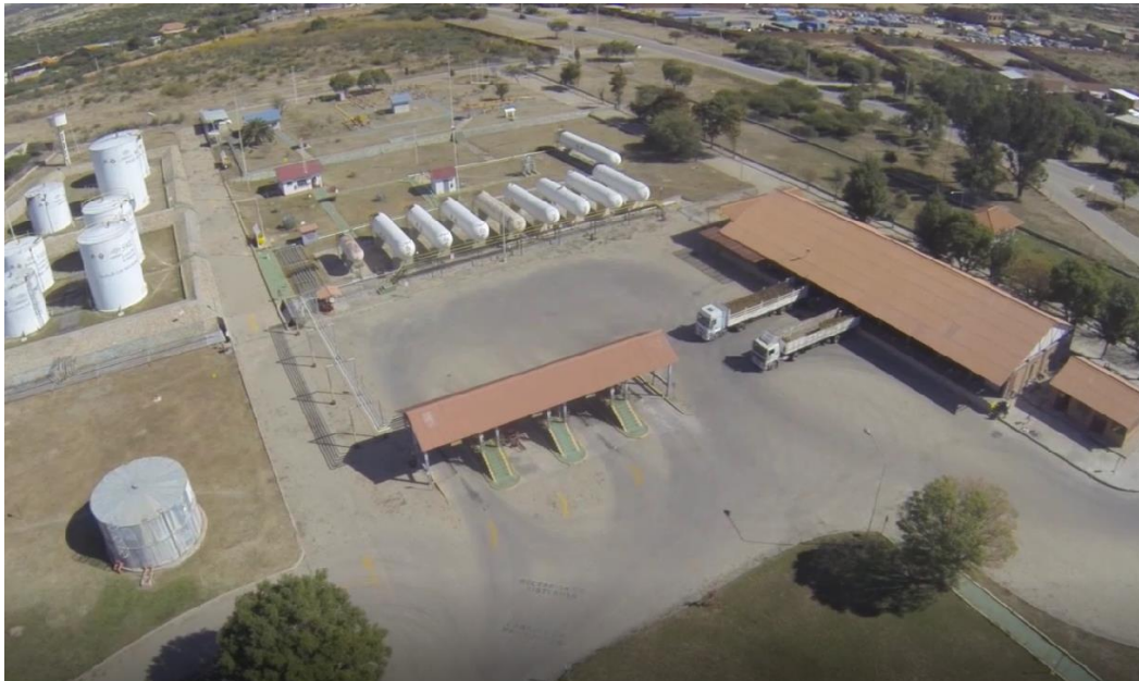
Figura 2.15 Vista aérea Planta engarrafadora
