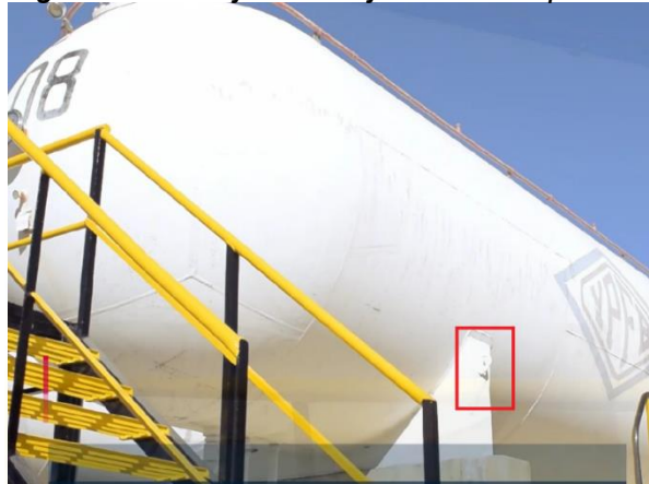
Figura 4.10 Orejas de izaje de un tanque
