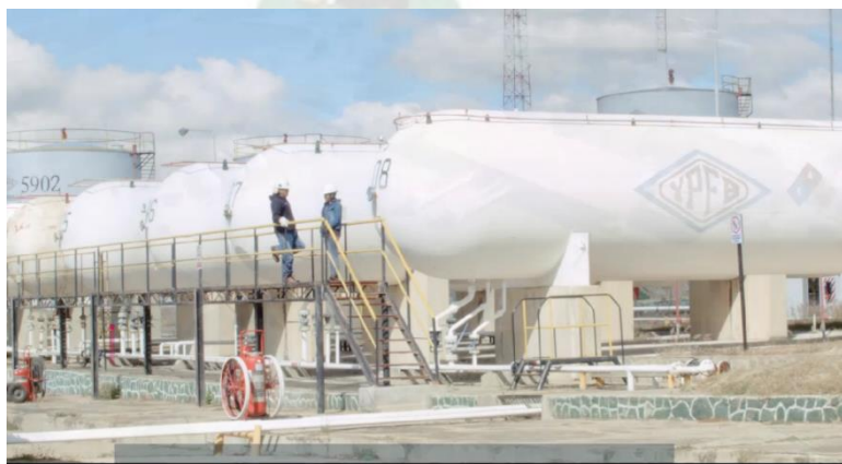
Figura 4.26 plataforma con gradas de los tanques
