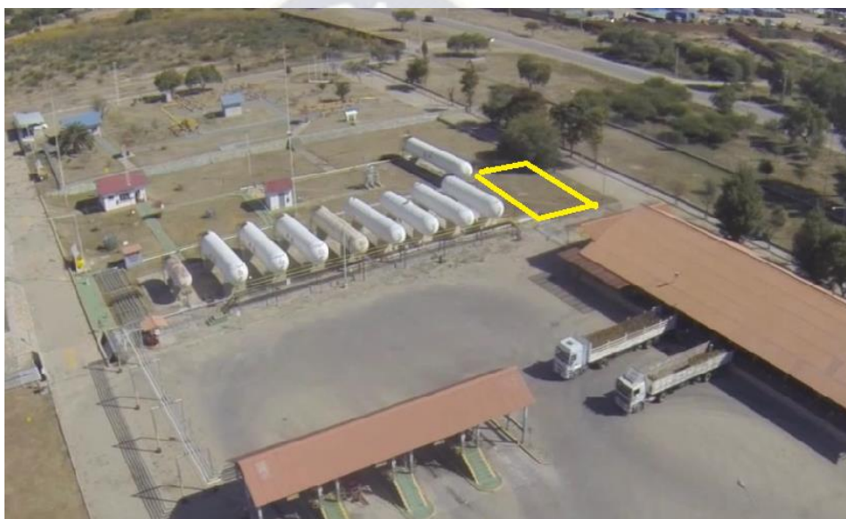
Figura 4.20 Área disponible para la instalación del tanque
