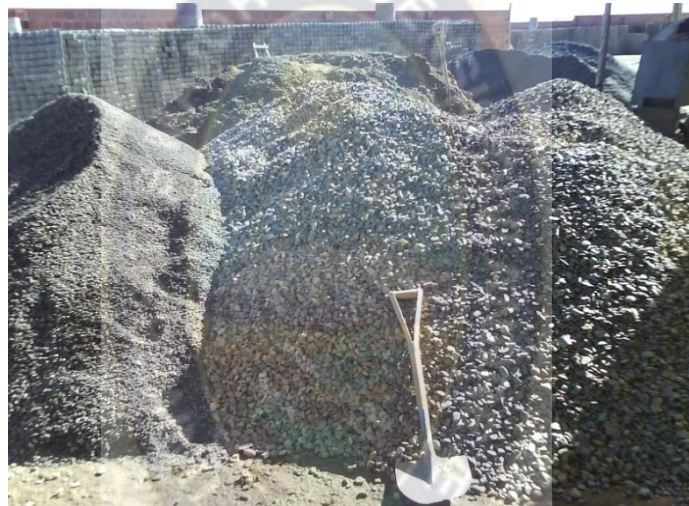
Figura 5 Agregados antes de la Mezcla
