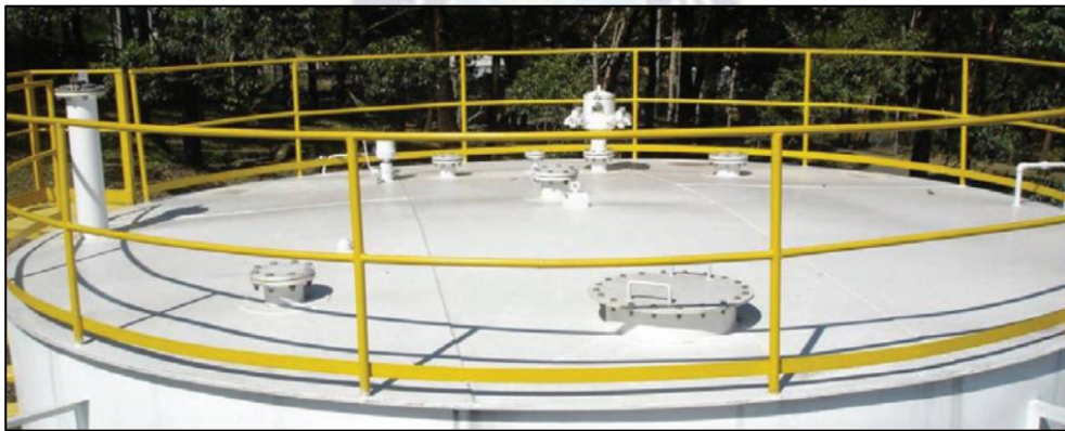
Figura 36. Aberturas del tanque de techo fijo. Fuente: La guía del ingeniero de tanques de almacenamiento
