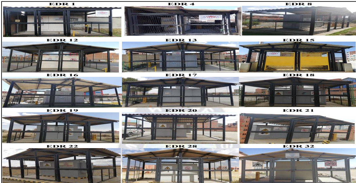
Figura 2-11 Compendio de fotografías de EDR's con cerco de malla.
