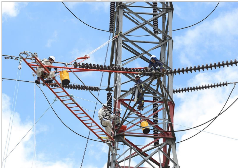
Figura 4.17: Montaje de torres de transmisión.
